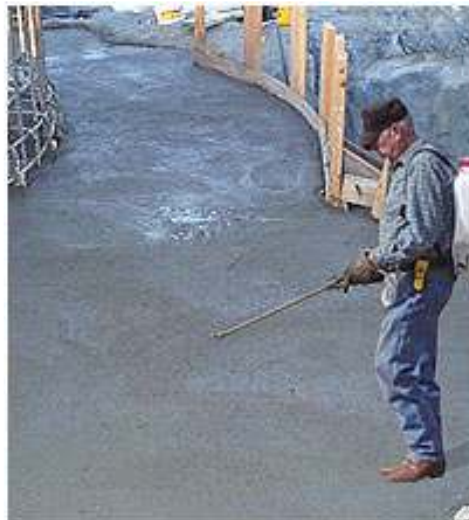
Colocación de una membrana de curado
