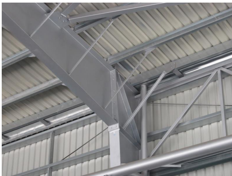
Figura 18. Soporte del cordón inferior de viga principal con tornapunta
