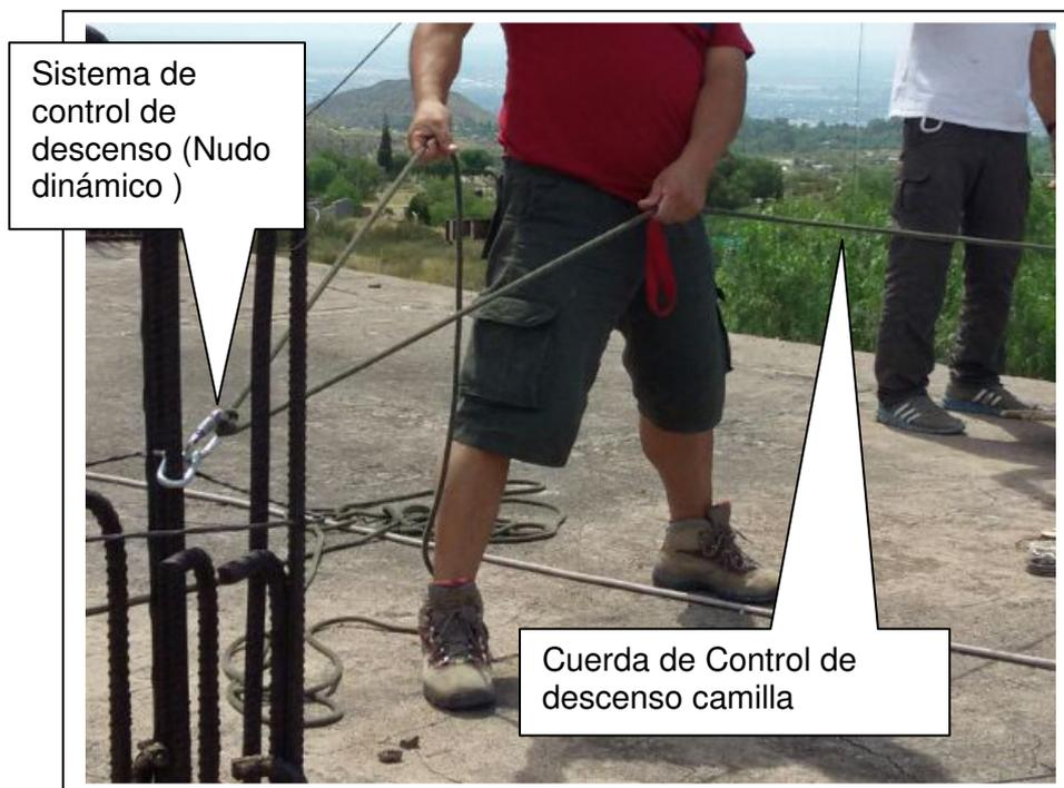
Fig Sistema de control de descenso
