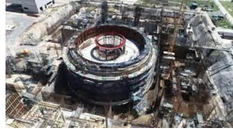
CAREM es el 1er. reactor nuclear de potencia íntegramente diseñado y construido en la Argentina. Son reactores de gran proyección para el abastecimiento eléctrico de zonas alejadas o de polos fabriles e industriales con alto consumo de energía (1ra versión: 32 MW)
