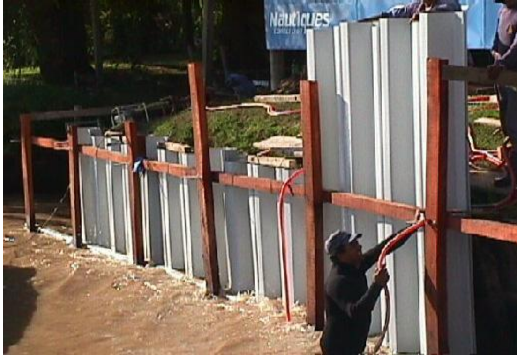
Apuntalamiento con tablestacado metálico
