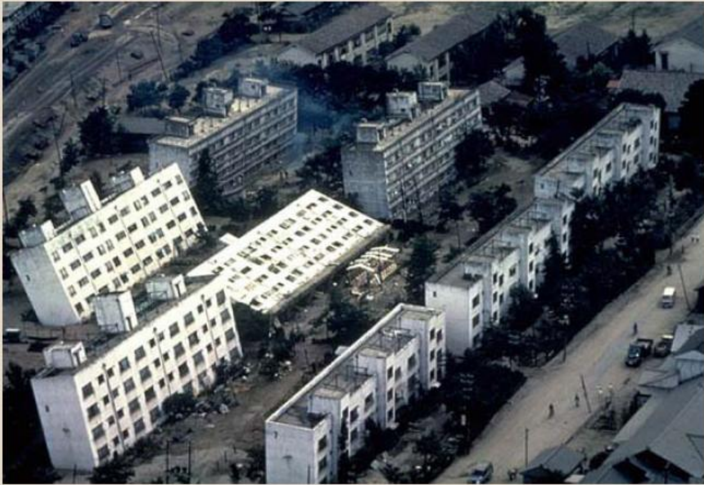
Licuefacción de suelos.- Terremoto de Niigata. 1964.
