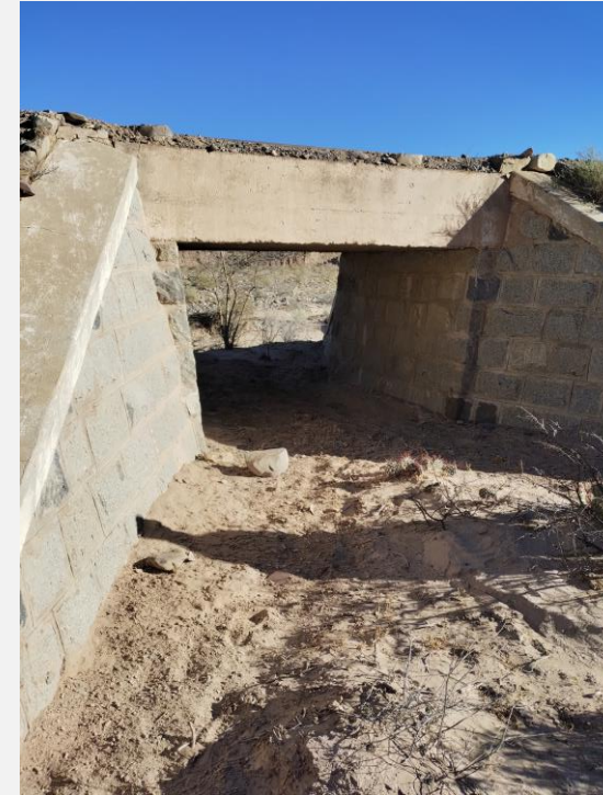
Alcantarilla de H°A° - Tablero cerrado
