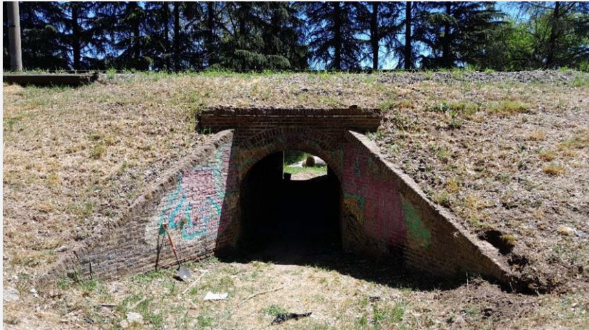
Alcantarilla Tipo Bóveda
