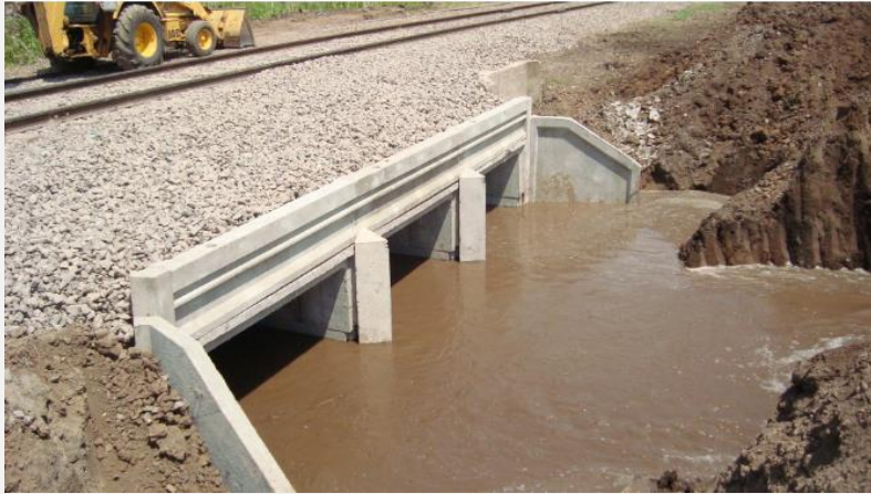
Alcantarilla Tipo cajón
