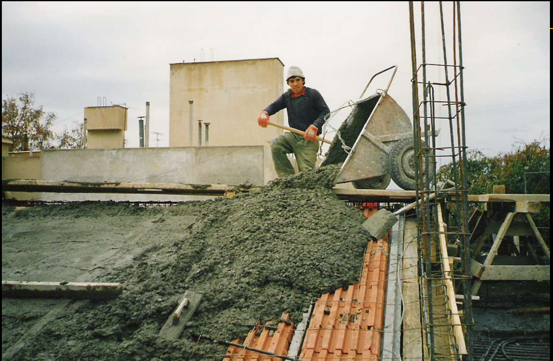
Colocación de hormigón mediante elevador y carretilla (balde)
