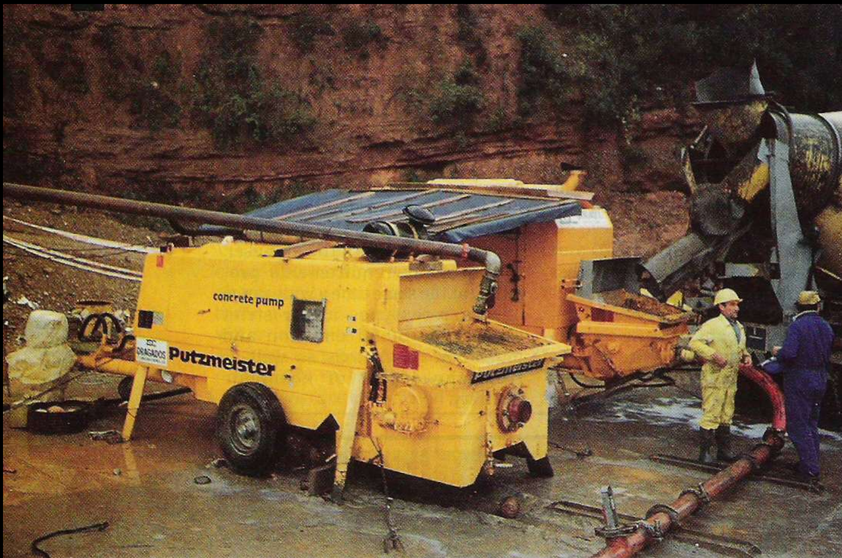
Colocación de hormigón mediante bomba fija
