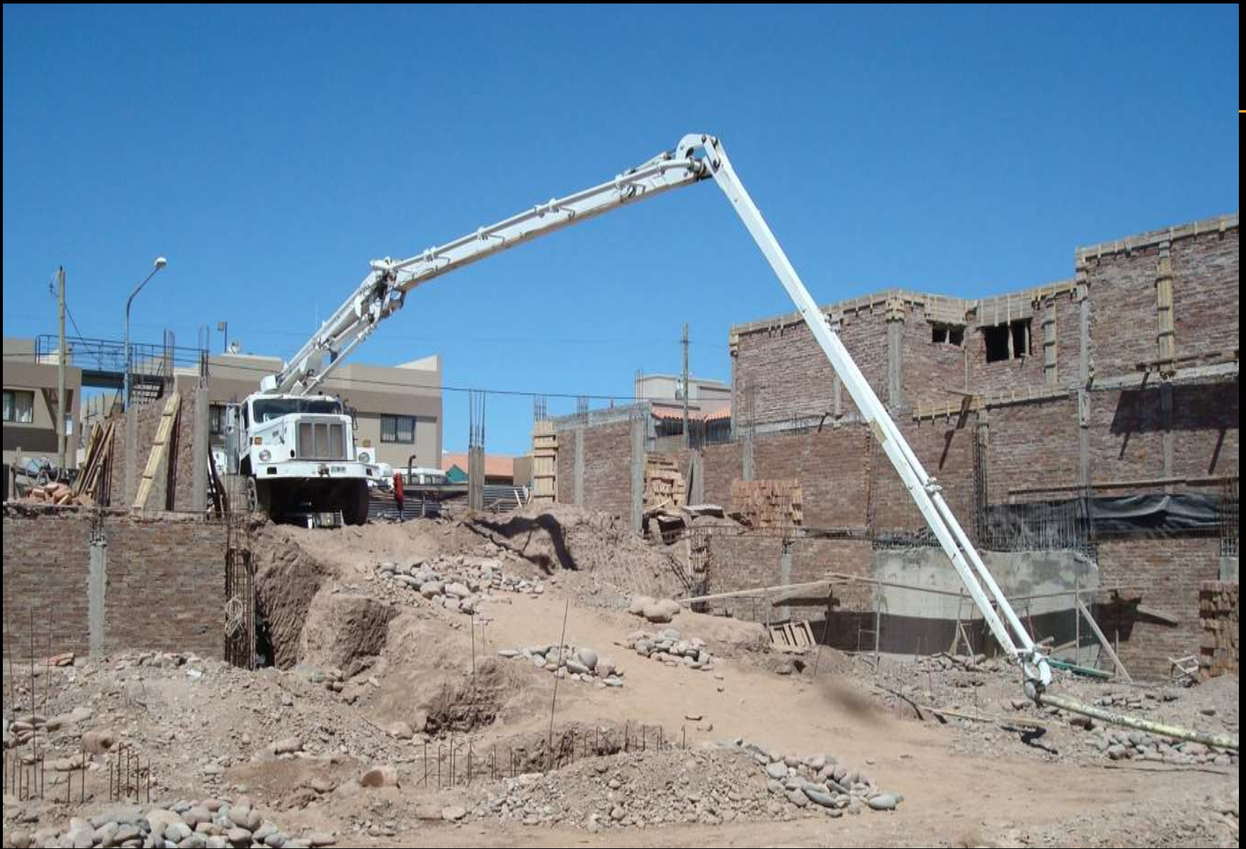
Colocación de hormigón mediante bomba móvil
