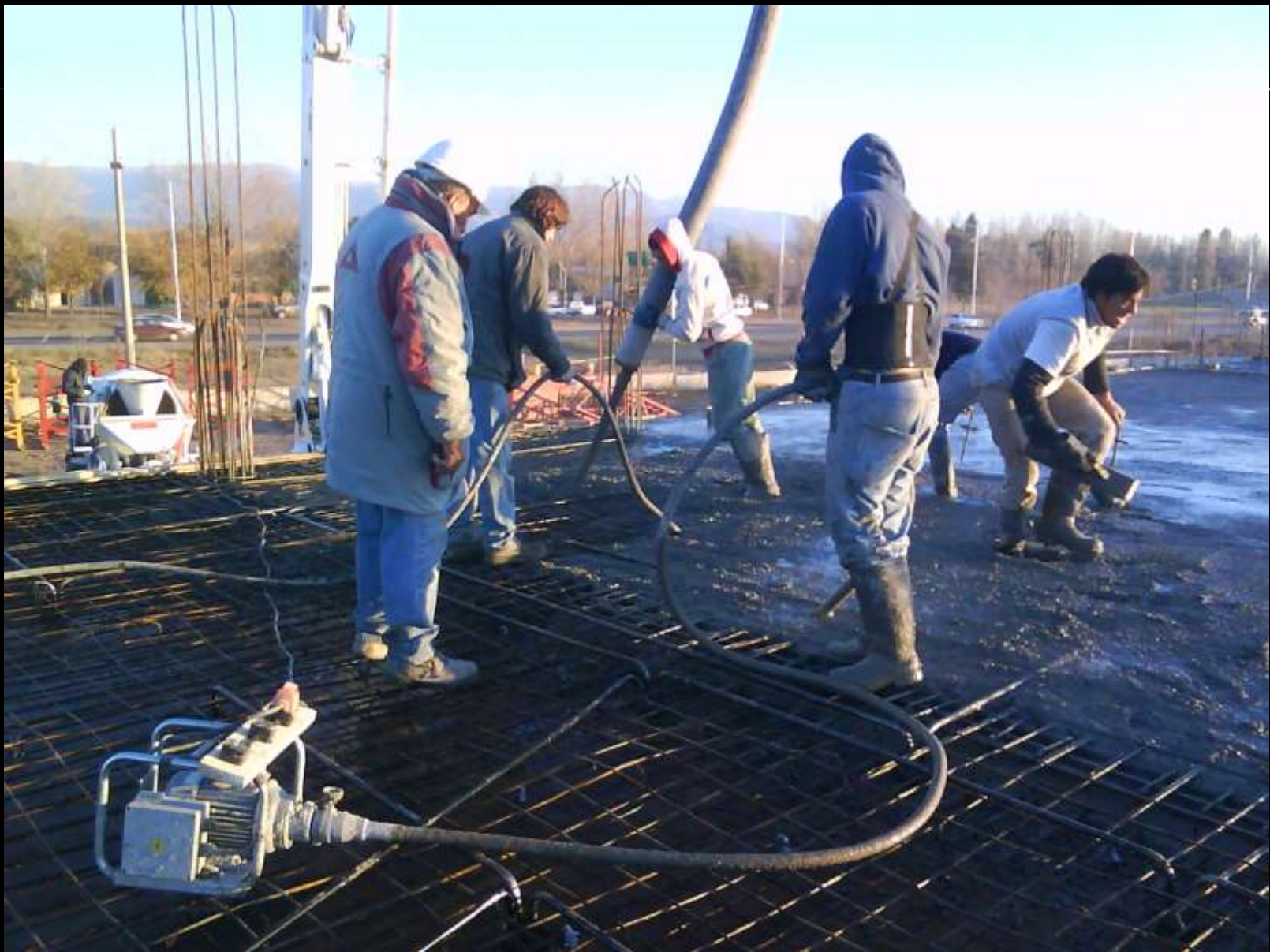
Colocación y vibrado de hormigón en losa
