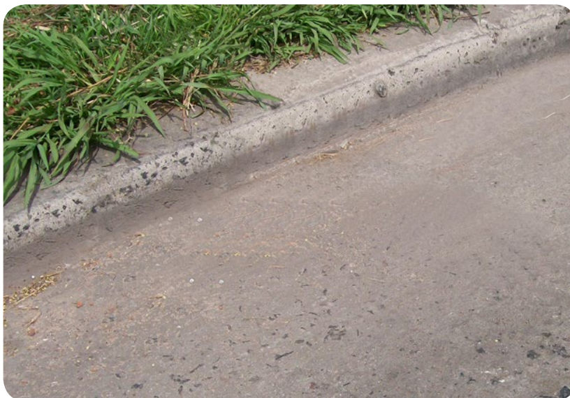
Detalle de cordón cuneta de hormigón.
