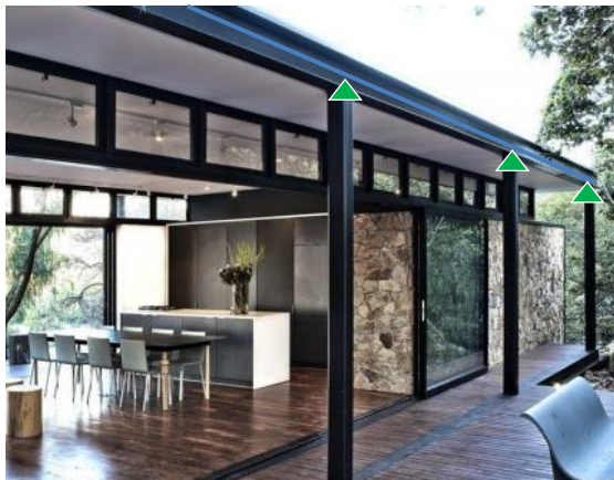
Fig. 4. Viga continua de Acero
