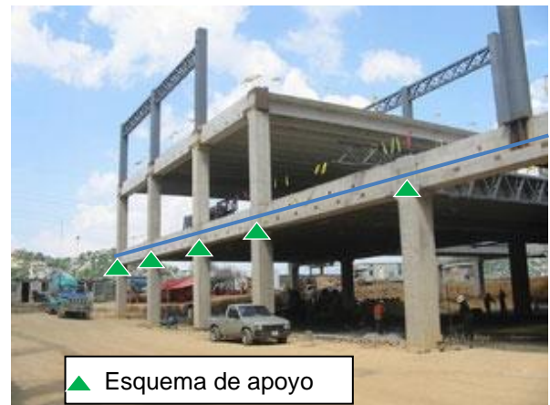
Fig 3- Viga continua de Hormigón (Edificio)
