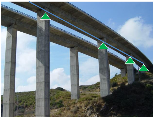
Fig. 2 Viga continua de Hormigón (Puente)
