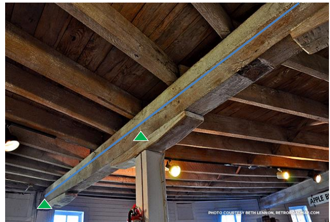
Fig. 5. Viga continua de madera
