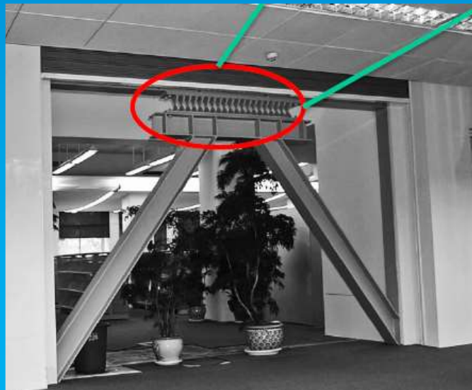
Aplicación en Wells Fargo. Dispositivo. Respuesta histerética Dispositivo ADAS.
