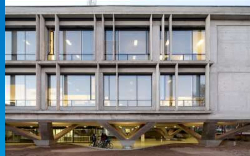
Edificio ONEMI - Chile Aisladores Elastoméricos
