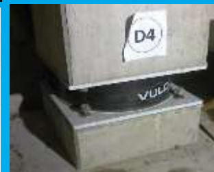
Edificio IHEM – UNCuyo . Mendoza Aisladores Elastoméricos y Péndulos de Fricción
