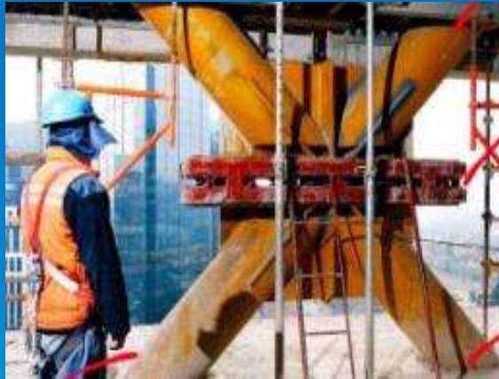
Edificio Titanium, Santiago de Chile. Disipador de placas plegadas.
