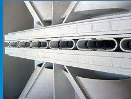
Edificio Titanium, Santiago de Chile. Disipador de placas plegadas.
