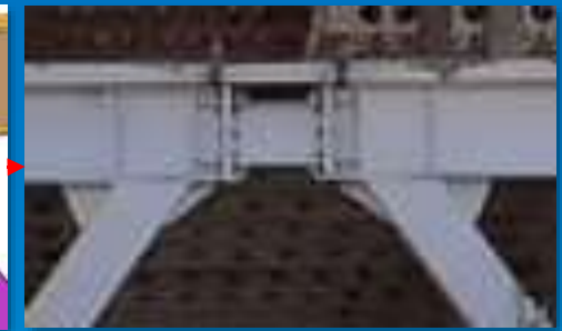
Detalle Enlace y conexión precalificada
