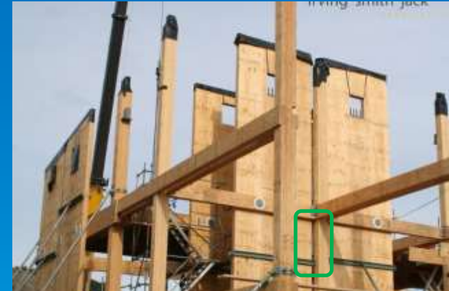
NMIT Building. Nueva Zelanda Muros madera postensados
