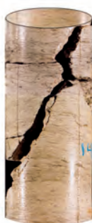
Figura 13. Coronas de pozo.
