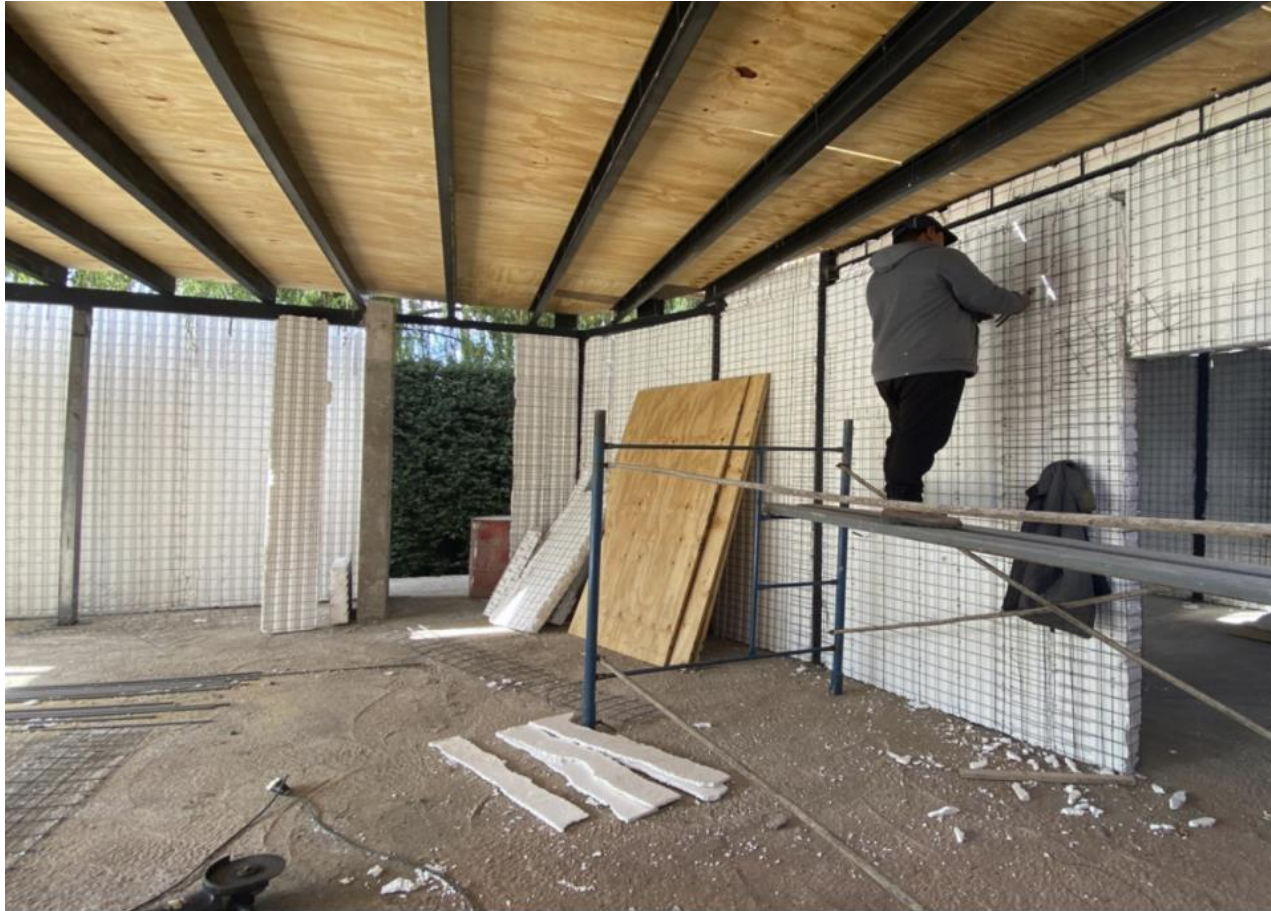
Montaje de Paneles
