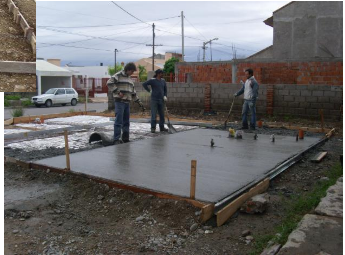
Armado de contrapiso -base
