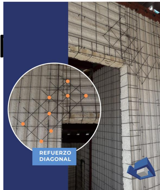
Vinculación entre Paneles
