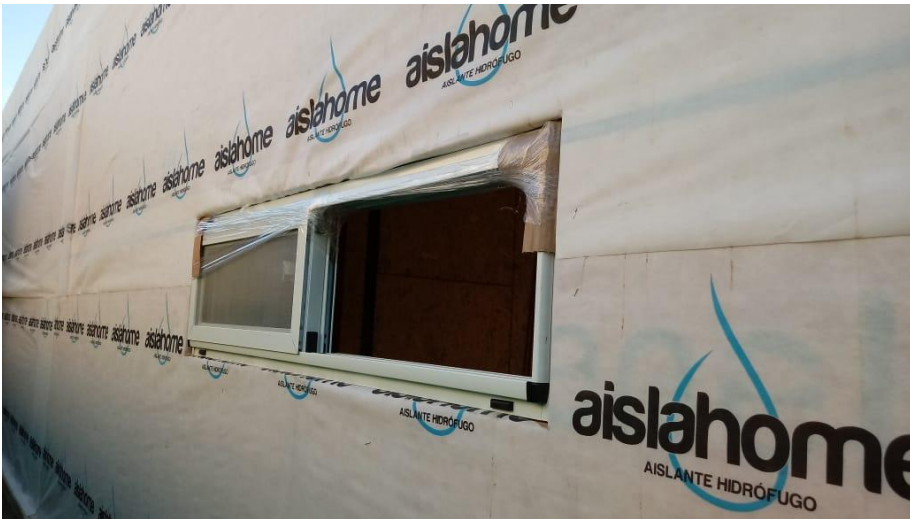
Colocación de paneles. Imagen interior, instalaciones sobre osb. Colocación de barrera de vapor. Panel terminación placa cementicia.
