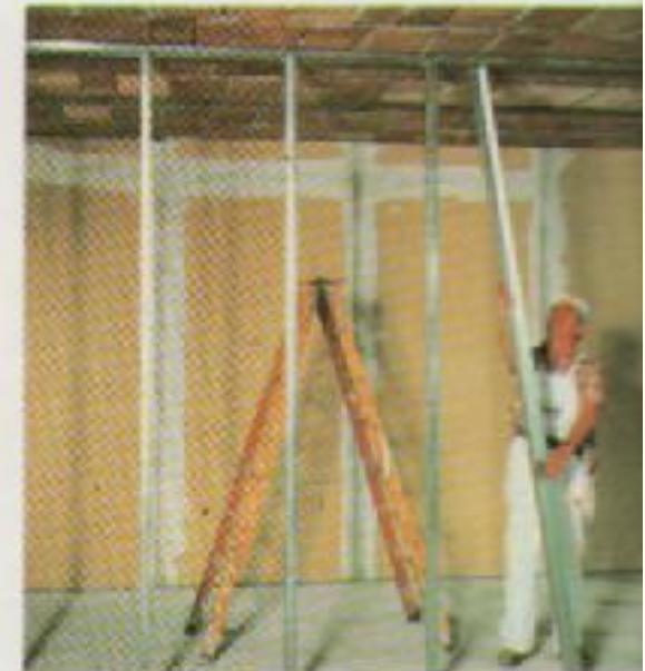
Estos tabiques son resistentes al fuego imagen, instalación de la armadura
