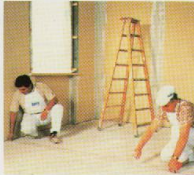
Toma de medidas para instalar tabiques prefabricados con estructura metálica
