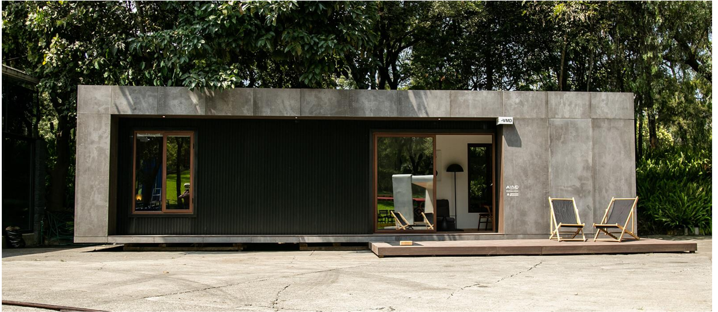
Vivienda modular terminación exterior placas cementicias , estructura interior metálica.
