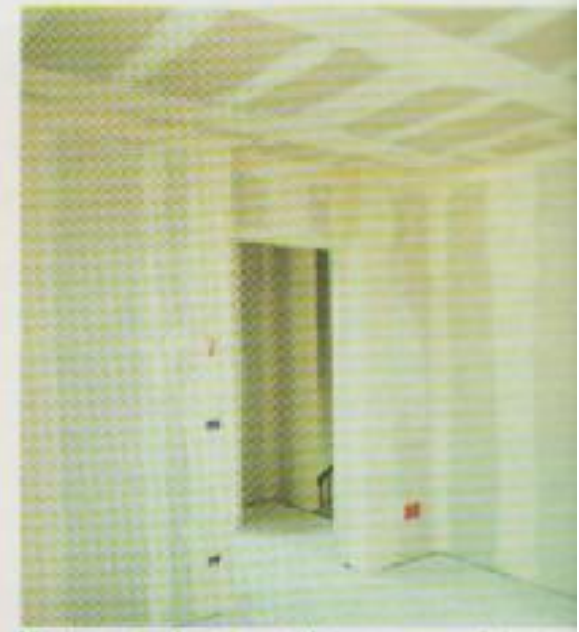
Estos tabiques son resistentes al fuego imagen, instalación de la armadura
