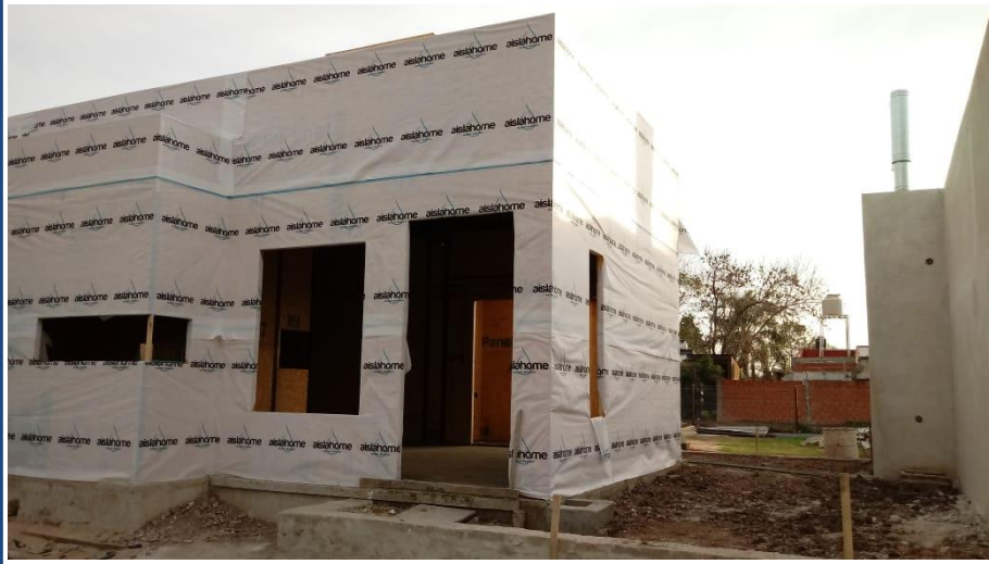
Colocación de paneles. Imagen interior, instalaciones sobre osb. Colocación de barrera de vapor. Panel terminación placa cementicia.
