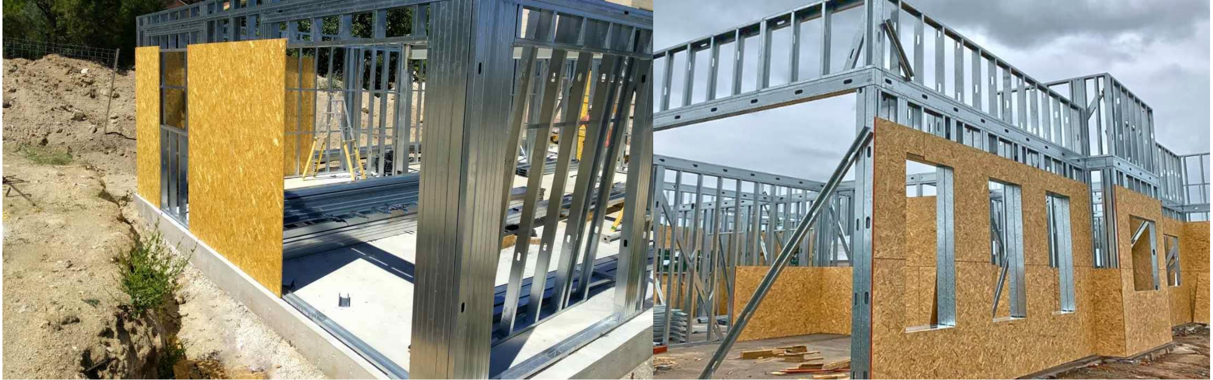
Cerramientos OSB exterior
