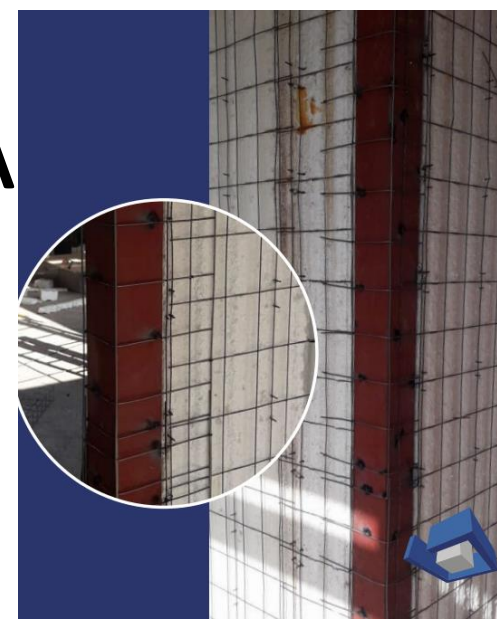
Vinculación Panel y columna
