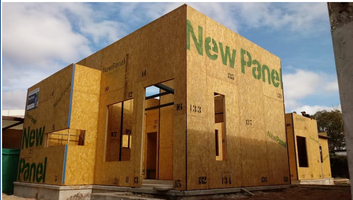
Colocación de paneles. Imagen interior, instalaciones sobre osb. Colocación de barrera de vapor. Panel terminación placa cementicia.
