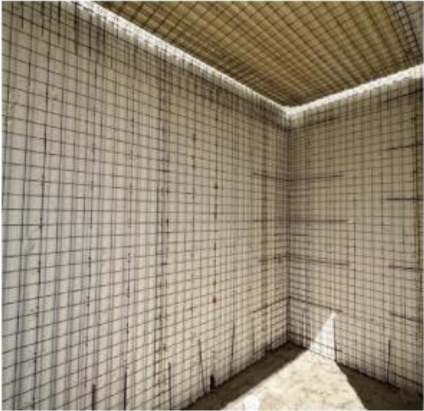
Muros y losas
