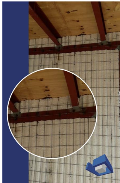
Vinculación Panel y viga
