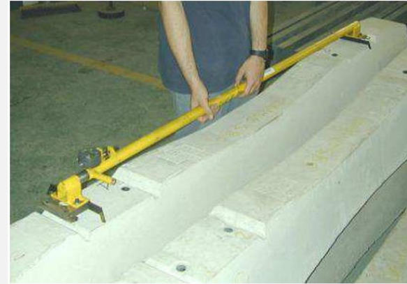
Verificación distancia entre puntos de la sujeción
