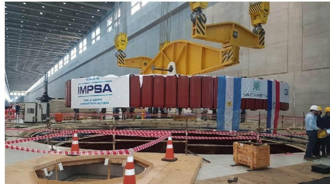
Rotor de Polos Salientes del Generador Sincrónico
