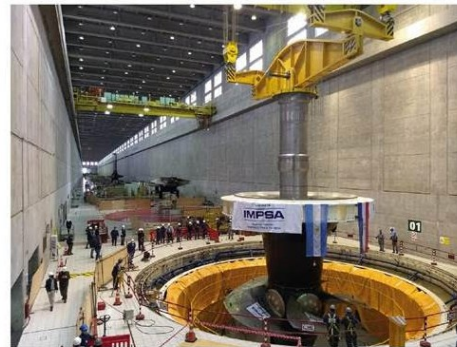
Nuevo Rodete de Turbina Kaplan 155 MW
