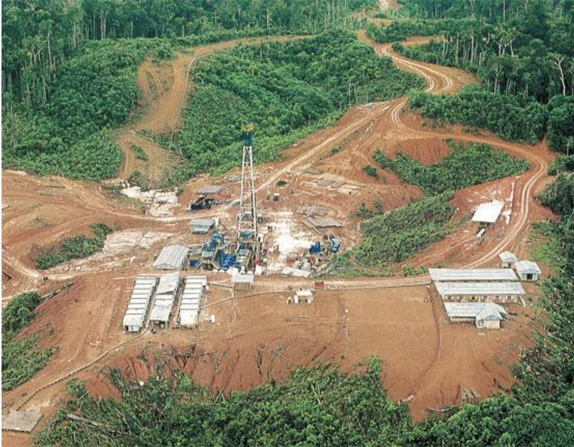
Locación de perforación en zona selvática
