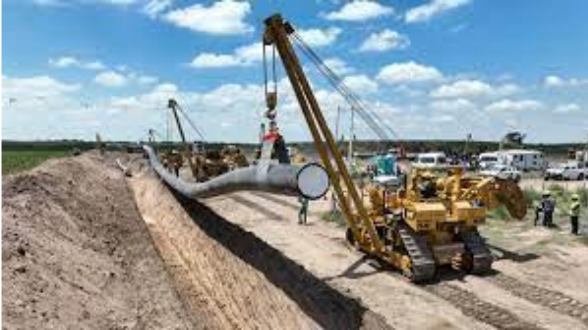
Tendido de ducto — cuadrilla de construcción
