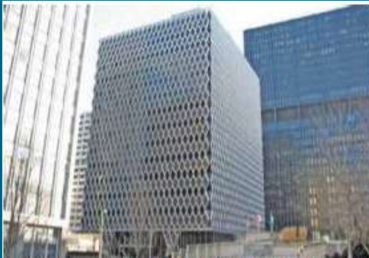
Figura 5.37.- Edificio IBM Pittsburgh, (SOM, 1963)
