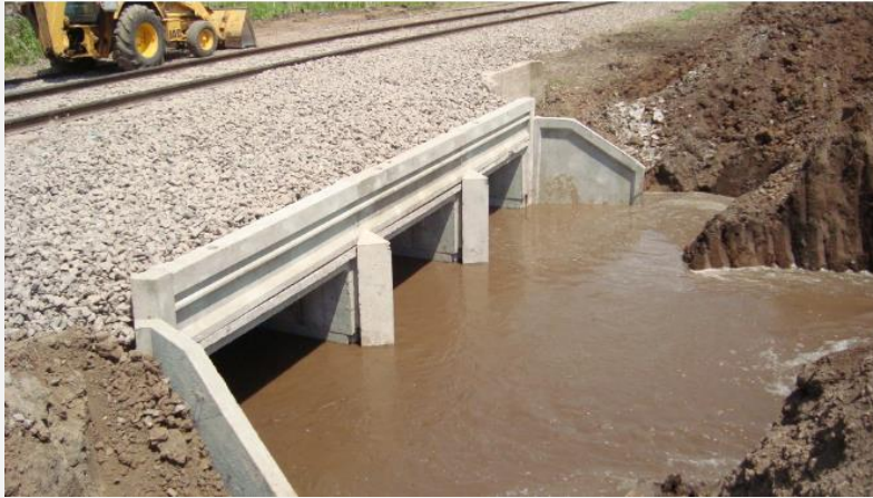
Alcantarilla Tipo cajón
