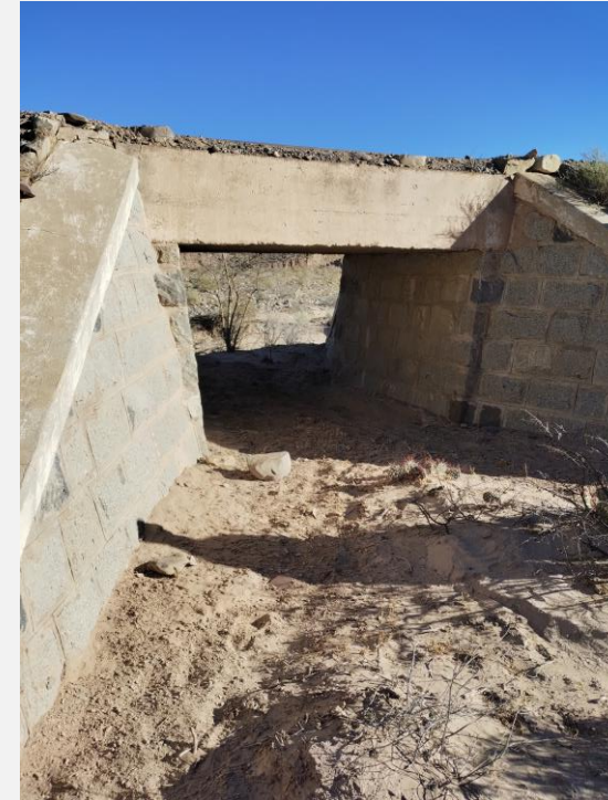
Alcantarilla de H°A° - Tablero cerrado
