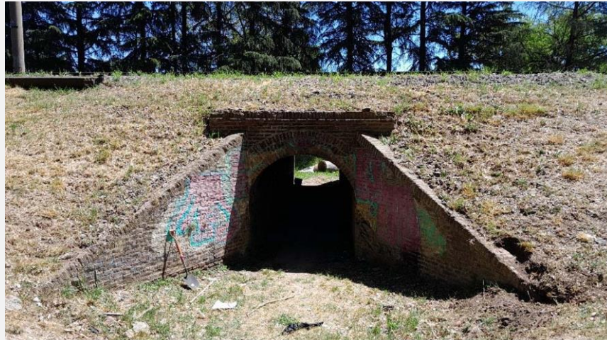
Alcantarilla Tipo Bóveda
