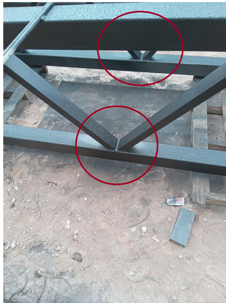
CONEXIÓN SOLDADA EN VIGA RETICULADA
