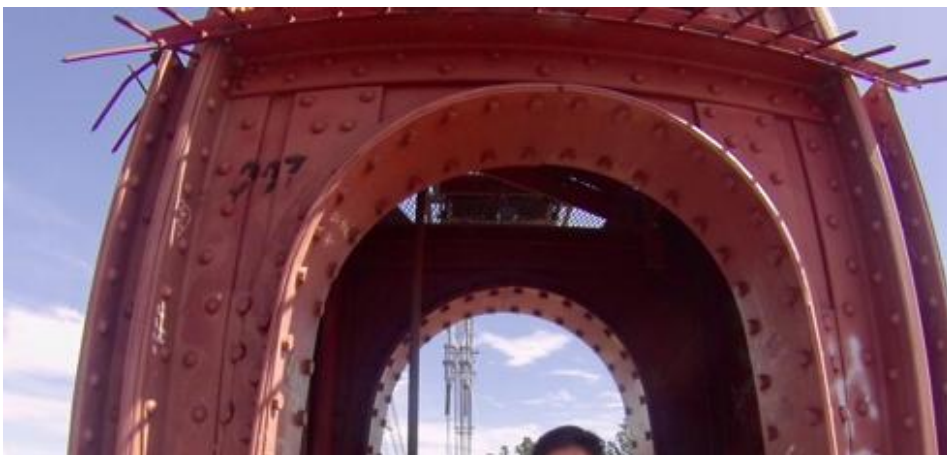
ESTRUCTURA DE ACERO REMACHADA
