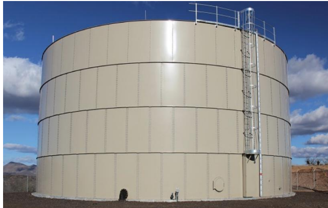
Tanques (piso y envolvente)
