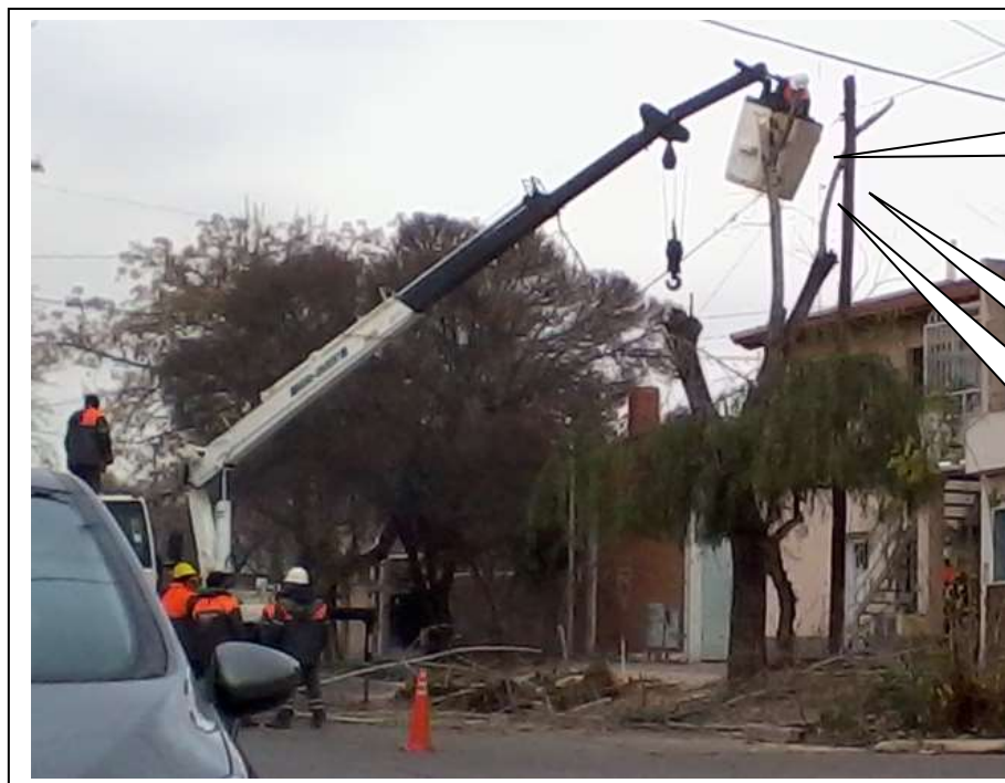
Fig Brazo hidráulico para el manejo de cargas con canasta (Prohibido)
