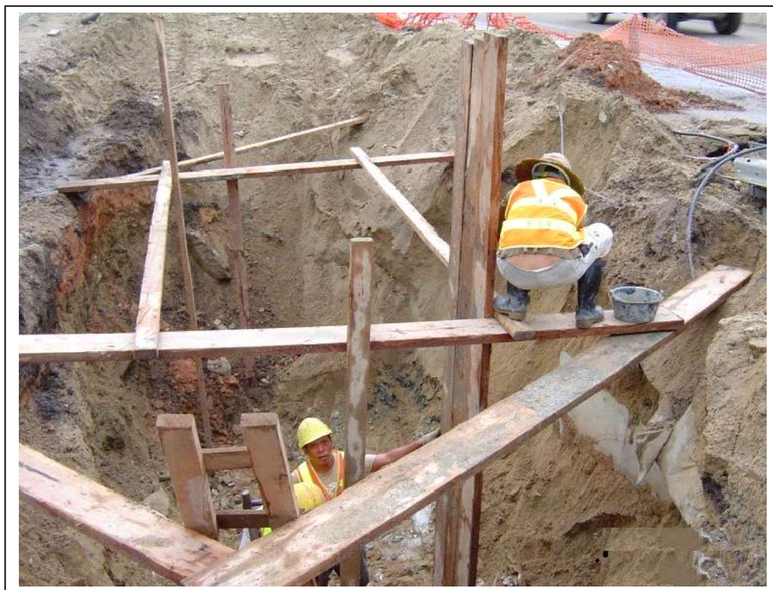
Fig Espacio confinado (trabajo en excavación)
