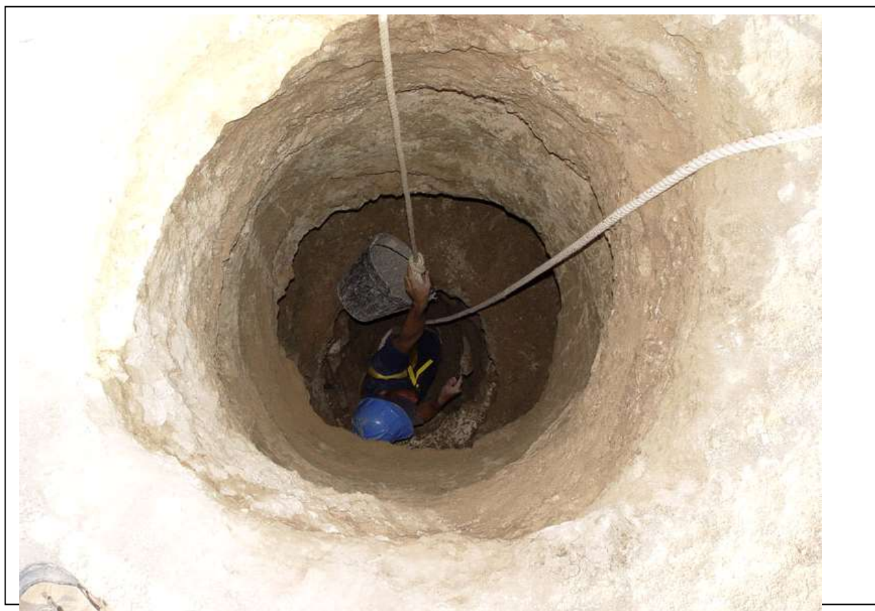
Fig Espacio confinado: Pozo
