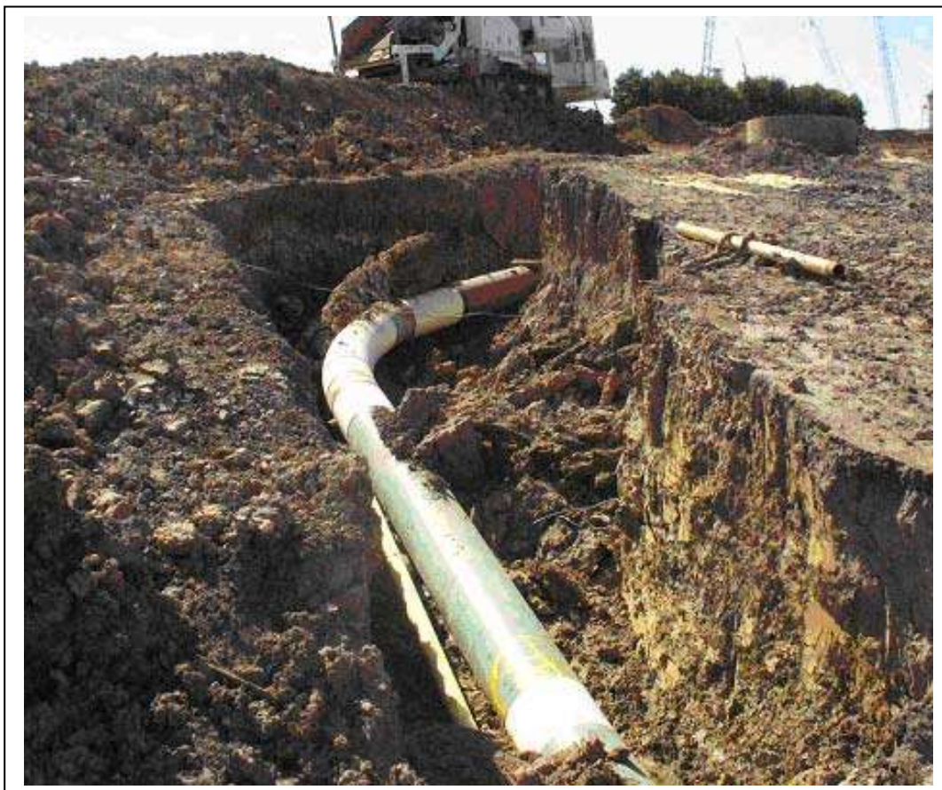
Fig Espacio confinado: Zanja
