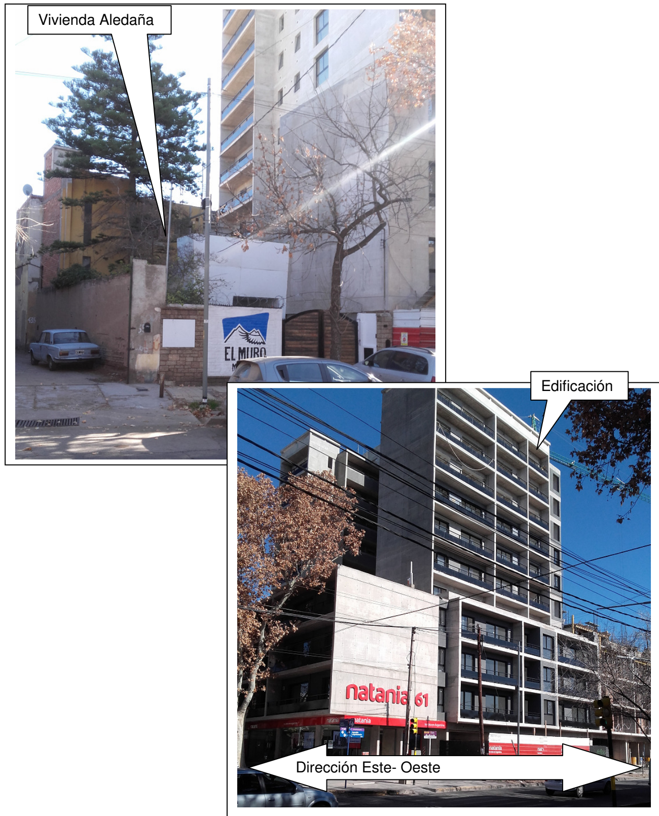
Fig 1.1 Impacto ambiental: edificaciones sobre viviendas aledañas
