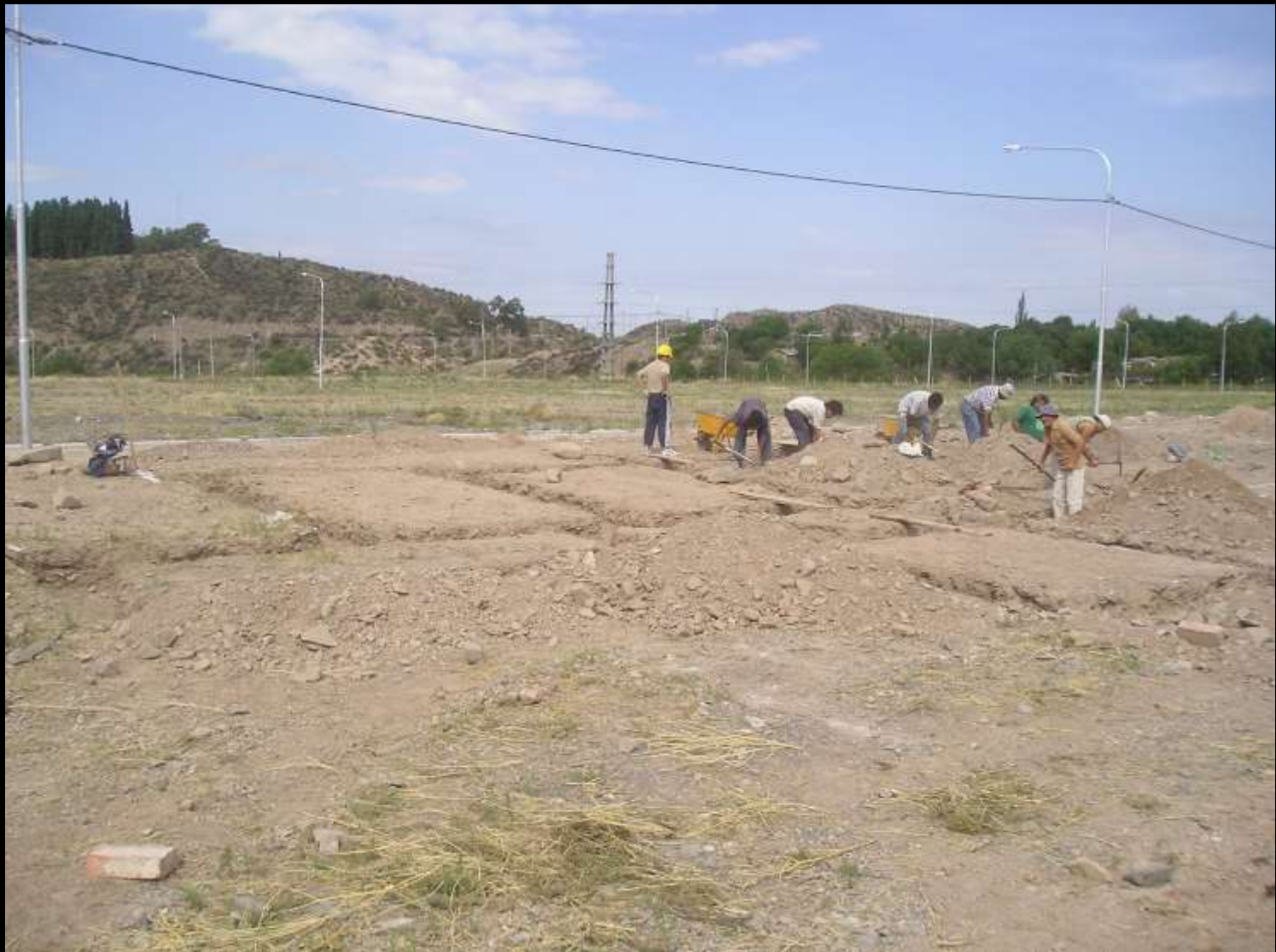
Excavación manual de bases y cimientos.
