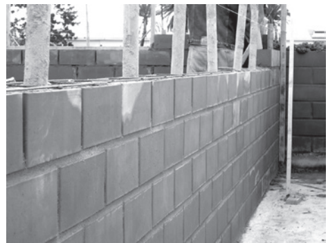
Figura 10.2 Unión de piezas de albañilería con mortero. (Gentileza de Hernán Levy).
