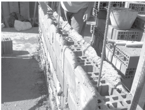
Figura 10.2 Unión de piezas de albañilería con mortero. (Gentileza de Hernán Levy).
