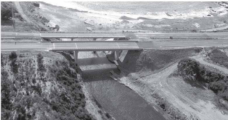
Figura 1.4 Obra civil. Puente Totoralillo, Ruta 5 Norte. Chile. (Gentileza Revista RIC).
