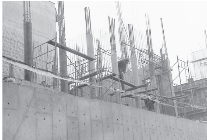
Figura 11.8 Obra de edificación de hormigón armado. (Gentileza de Eduardo Effa).
