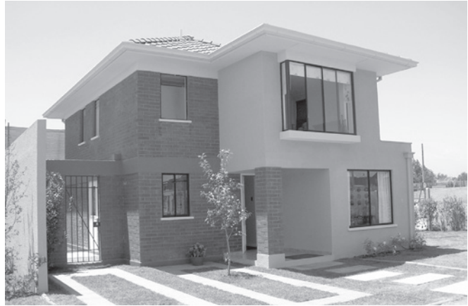
Figura 10.1 Construcción de albañilería. (Gentileza de Hernán Levy).
