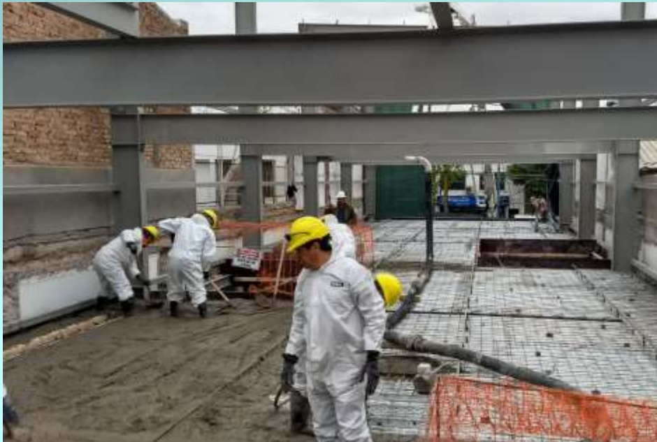
Colocación de Hormigón Elaborado
