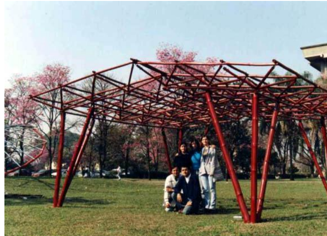
Reticulado Espacial en cubierta de techo y columnas.
