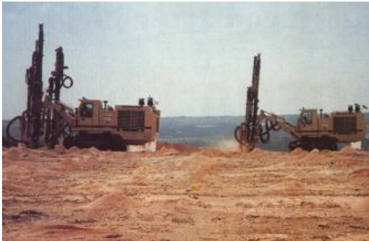
Perforación de barrenos
