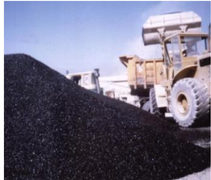
Detalle de acopio de mezcla
