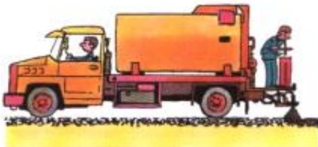
Adición de emulsión
