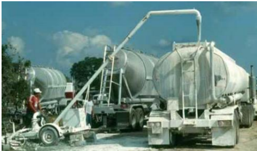
Carga de la lechada en el camión
