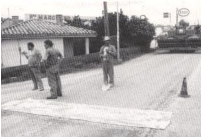
Antes de iniciar el riego
