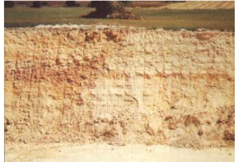
Talud precortado
