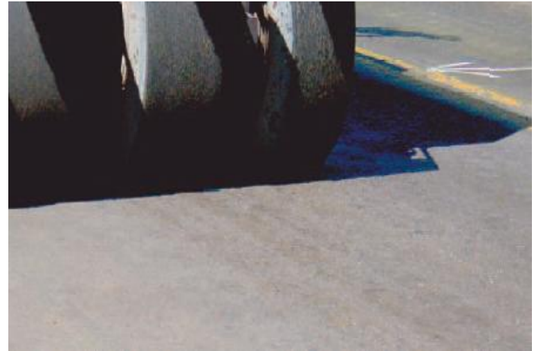
Compactación de cierre
