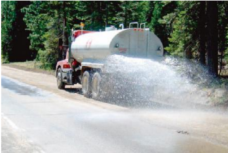
Humedecimiento ligero de la capa compactada
