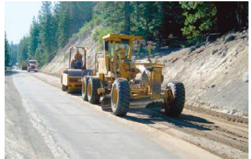
Nivelación y compactación principal
