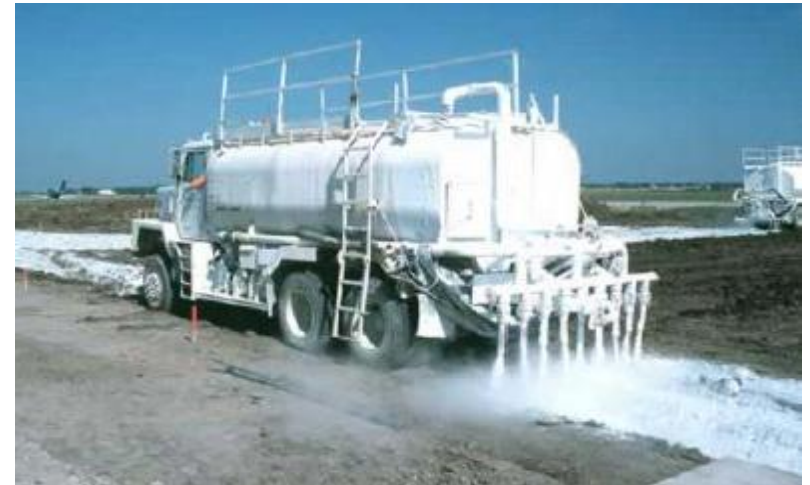
Aplicación de la lechada
