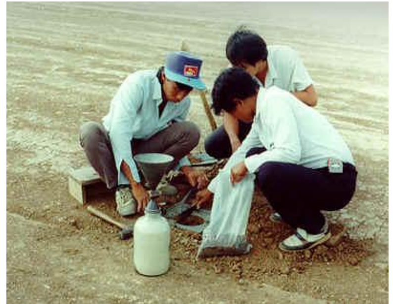
Verificación de la densidad
