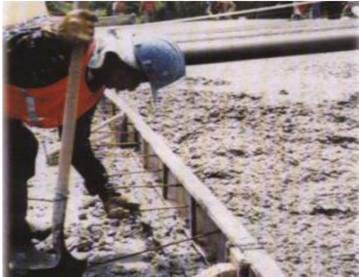
Inserción manual en pavimento construido con formaleta fija
