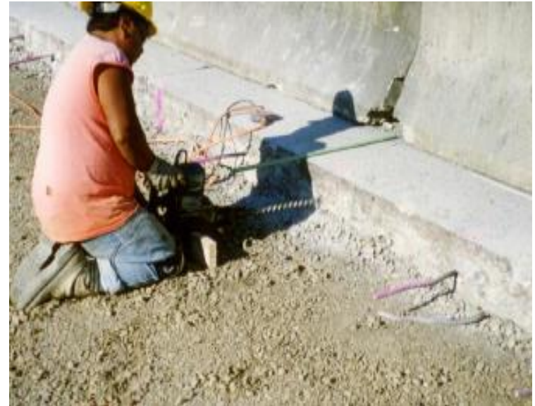
Perforaciones para inserción de varillas en concreto endurecido
