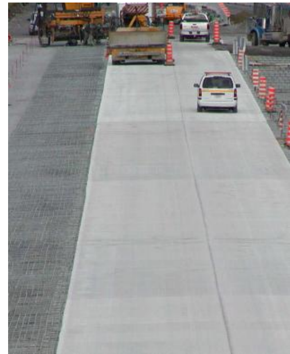
Concreto con refuerzo continuo
