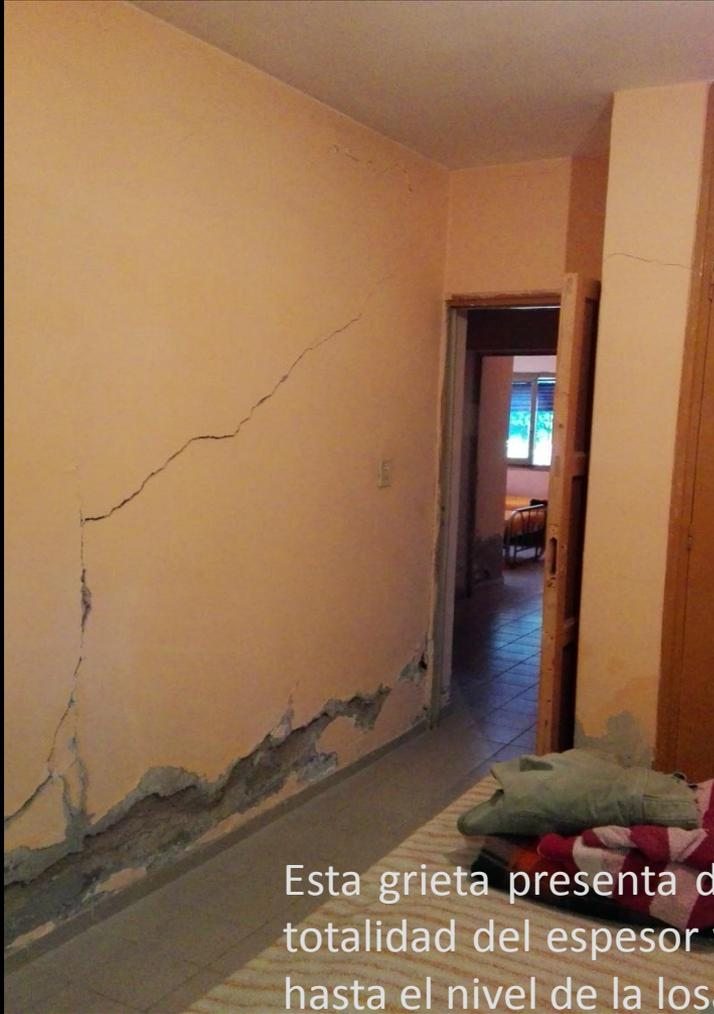
Esta grieta presenta dirección a  $45^\circ$ , atraviesa la totalidad del espesor y se extiende desde el piso hasta el nivel de la losa.
