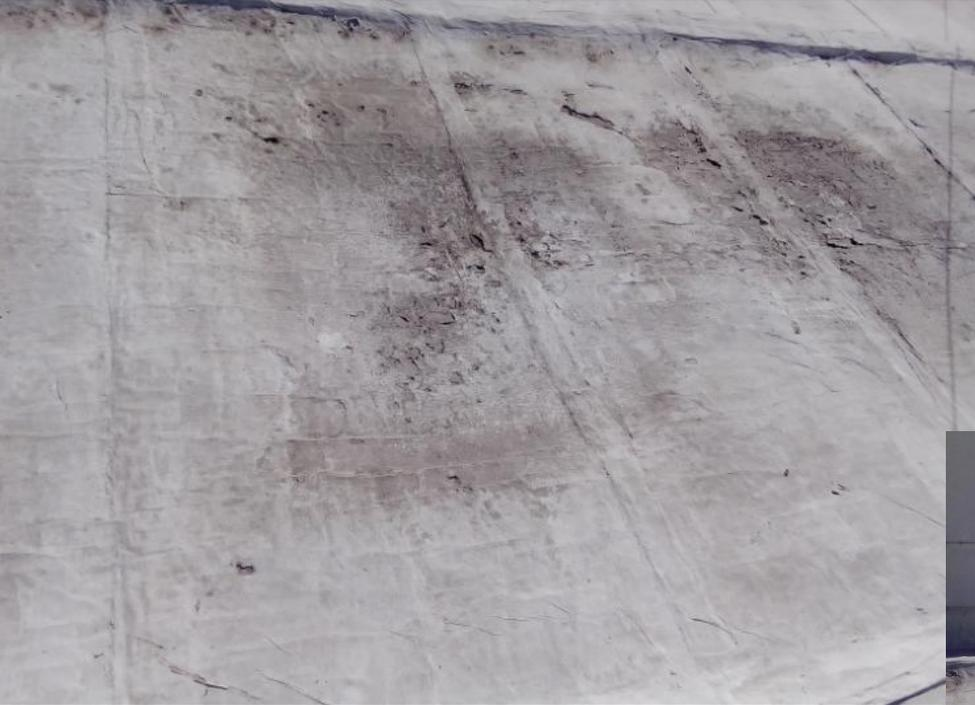
Rotura de la Membrana y hundimiento localizado de la cubierta
