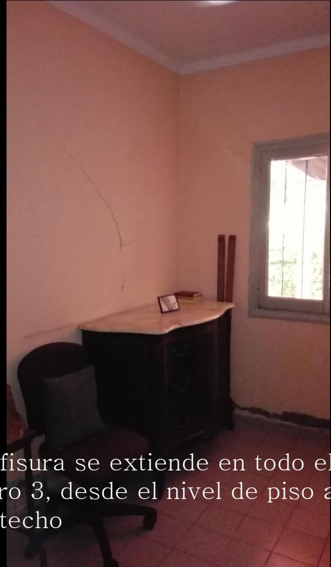
La fisura se extiende en todo el muro 3, desde el nivel de piso al de techo
