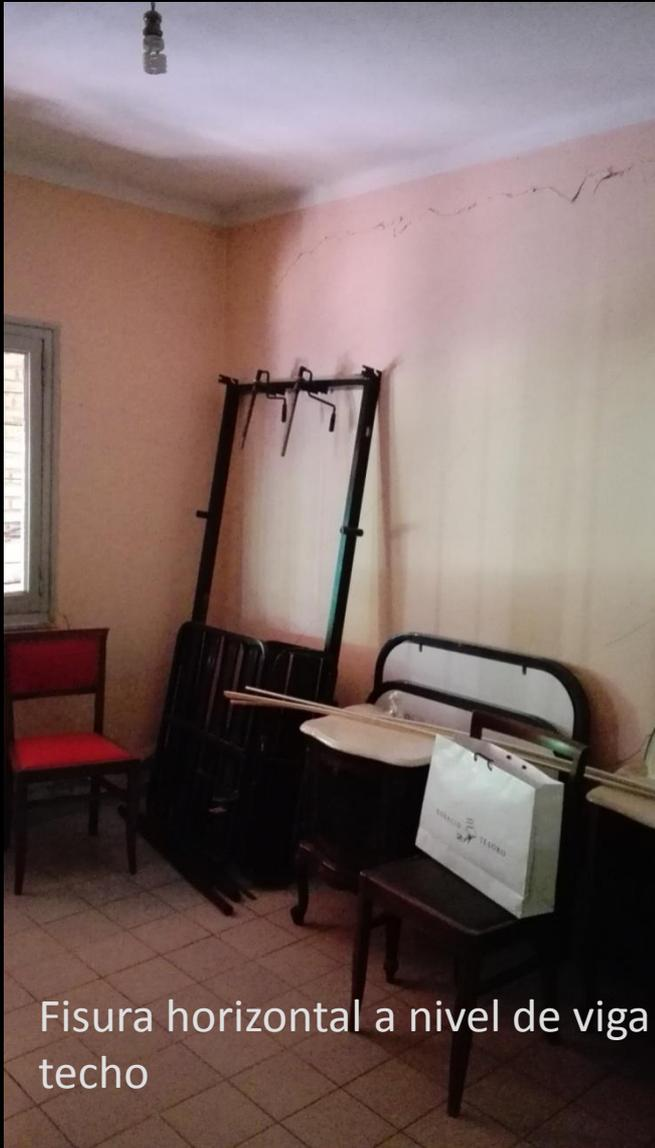
Fisura horizontal a nivel de viga de techo
