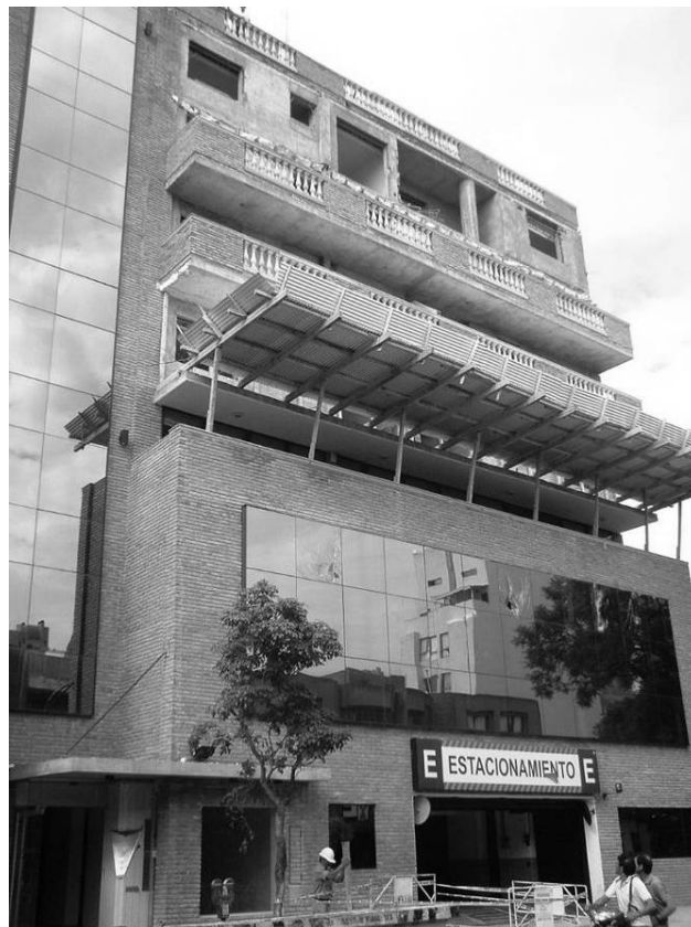
Fig. 16 – Vista exterior con una bandeja para la construcción de los nuevos balcones tras su derrumbe
