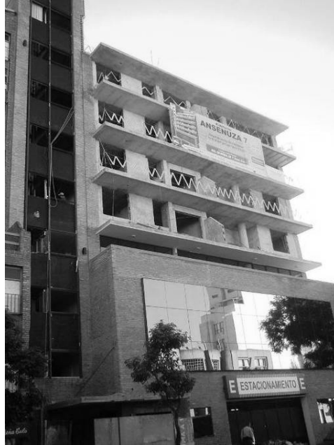
Fig. 12 - Vista exterior con el alero realizado
