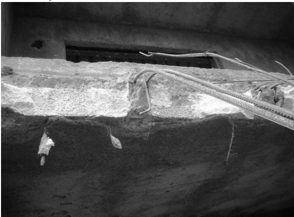
Fig. 13 y 14 – Detalle de la armadura que quedó tras la demolición del balcón de 6º piso.
