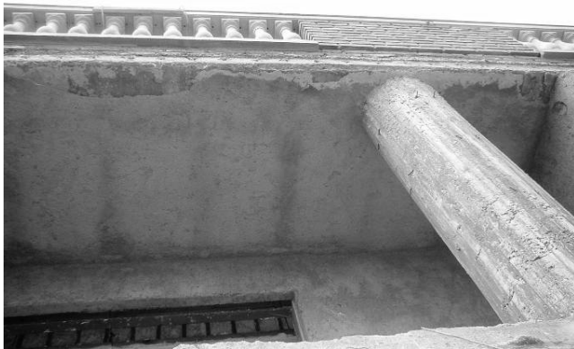
Fig. 17 y 18 – Borde de viga donde quedaron los agujeros de los anclajes y restos de la losa que cayó a planta baja con los anclajes arrancados.
