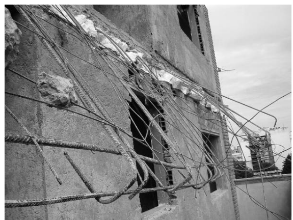
Fig. 13 y 14 – Detalle de la armadura que quedó tras la demolición del balcón de 6º piso.
