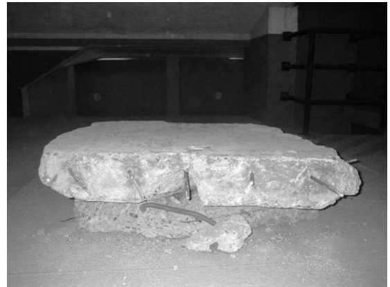
Fig. 17 y 18 – Borde de viga donde quedaron los agujeros de los anclajes y restos de la losa que cayó a planta baja con los anclajes arrancados.
