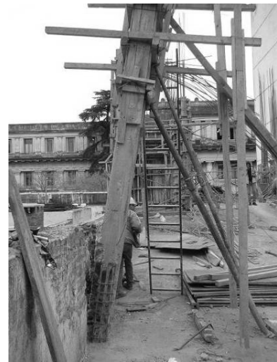
Fig. 6 – Estado de las columnas
