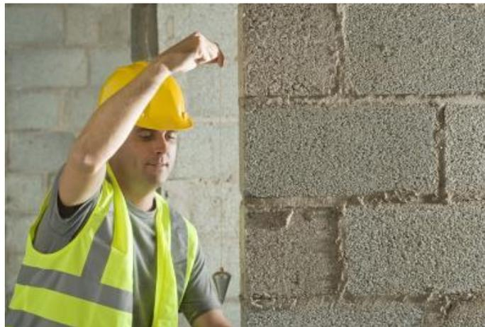
Figura N°9: verificación de verticalidad de un muro con plomada
