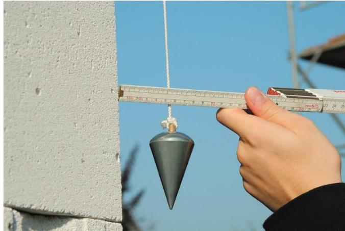
Figura N°8: verificación de verticalidad con plomada
