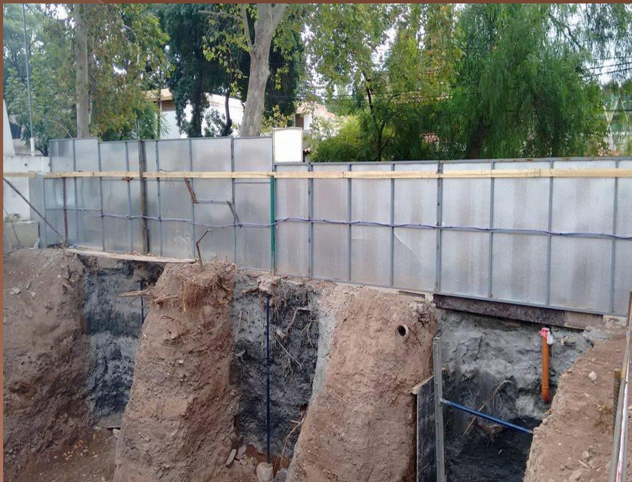
Controlar la colocación de encofrado con refuerzo de apuntalamiento en su parte inferior para evitar desplazamiento por peso o impacto del material.
