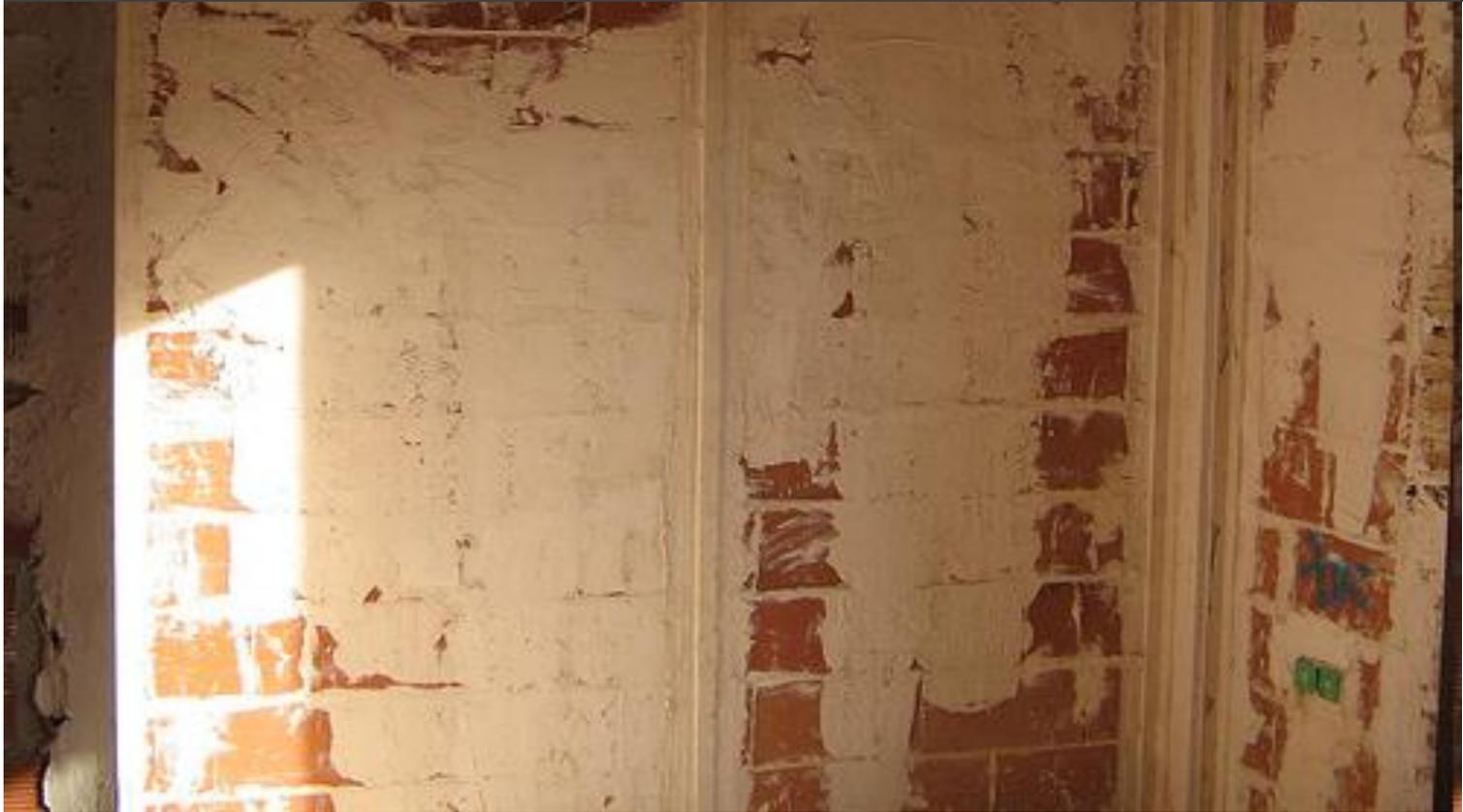
Yeso con guías: utilización de guías , fajas o listones verticales de madera que se colocan previamente en la pared con el fin de asegurar un grosor homogéneo de la capa de yeso. En estos casos, se aplica el yeso y se nivela pasando por la superficie una regleta que se va apoyando en las maestras.
