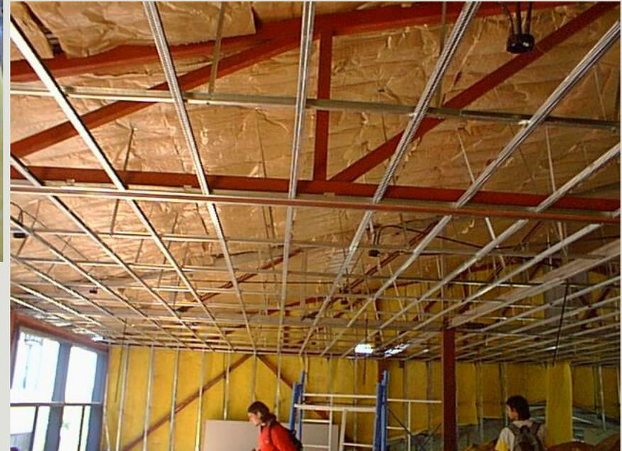
**Cielorraso suspendido de estructura metálica**
