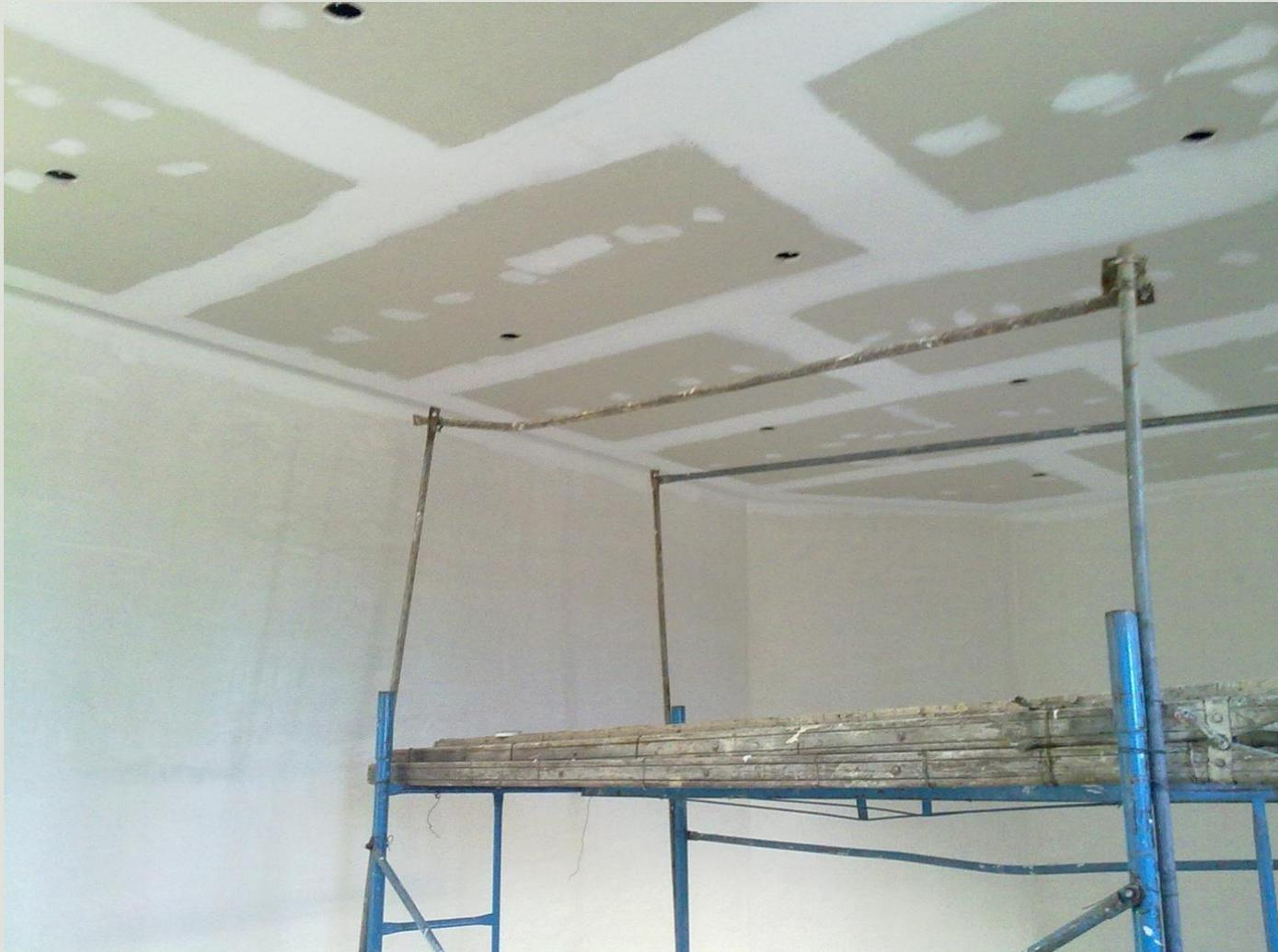
**Emplacado de cielorraso suspendido, con placas de roca de yeso**
