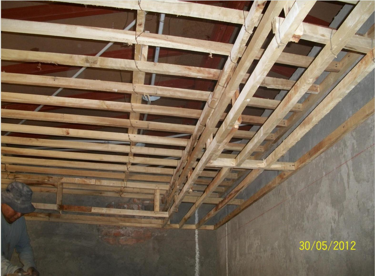
**Cielorraso suspendido de estructura de madera**
