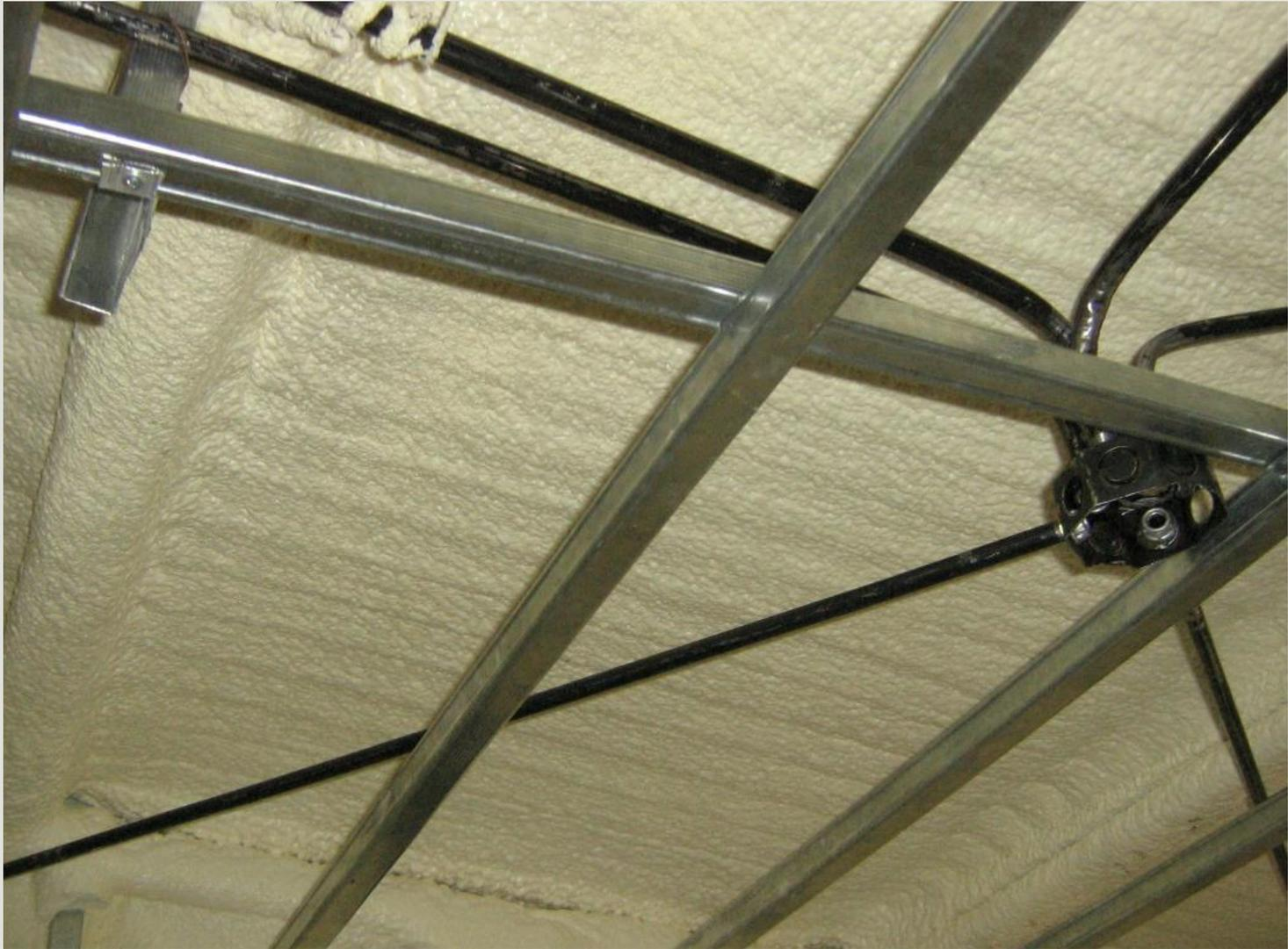
**Cielorraso suspendido con aislación de poliuretano en cubierta.**
