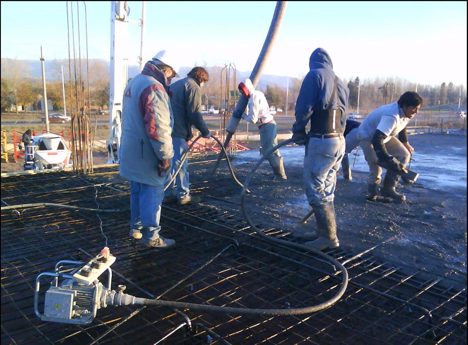
Vibradores para hormigón
