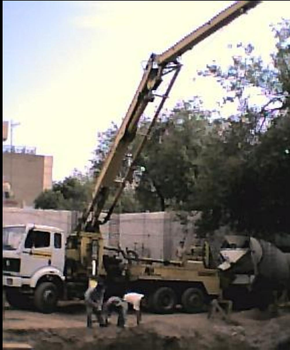
Bomba móvil para elevación de hormigón
