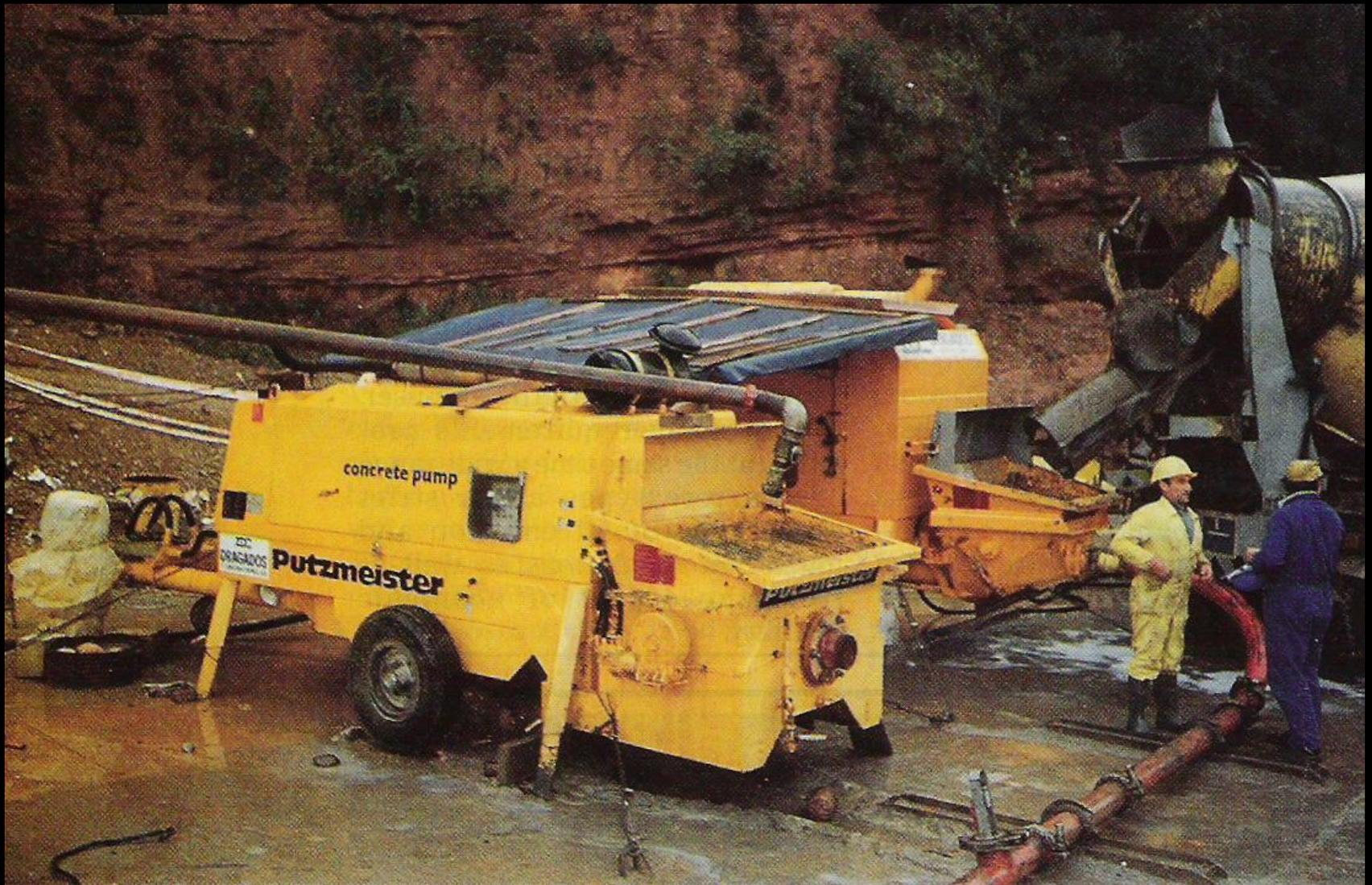
Bomba fija para elevación de hormigón
