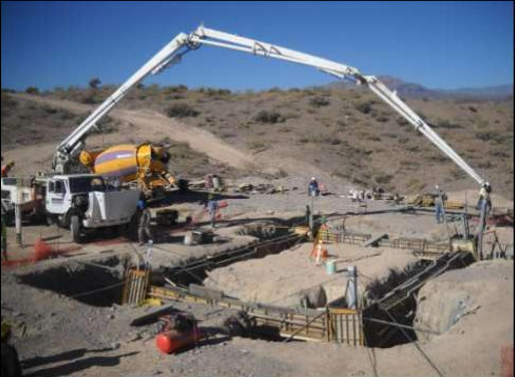
Bomba móvil para elevación de hormigón
