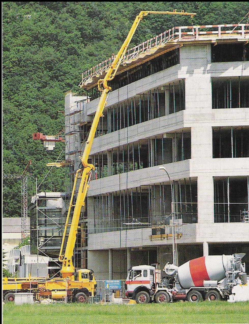
Bomba móvil para elevación de hormigón
