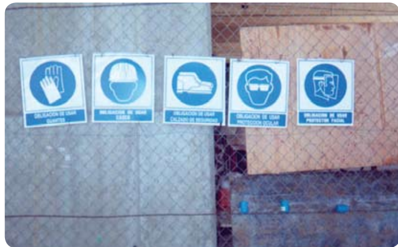
Señalización en obra de uso obligatorio de EPP.
