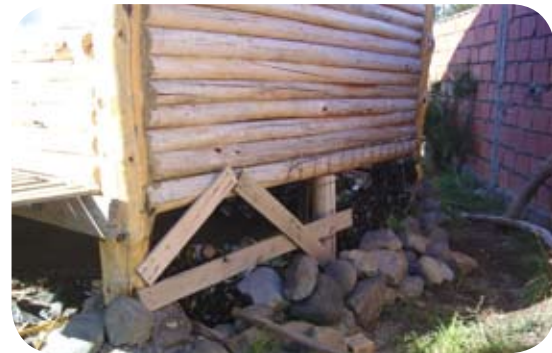
Vivienda: con aislación térmica por medio de la recuperación de botellas.
