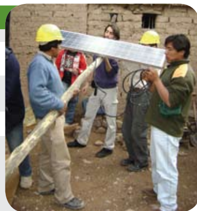
Colocación: de paneles solares fotovoltaicos en Nazareno Salta. Convenio Fundación UOCRA-PNUD.
