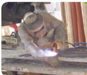
EPP: para trabajos de soldadura.
