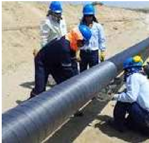
Figura 19: Revestimiento anticorrosivo de cañerías
