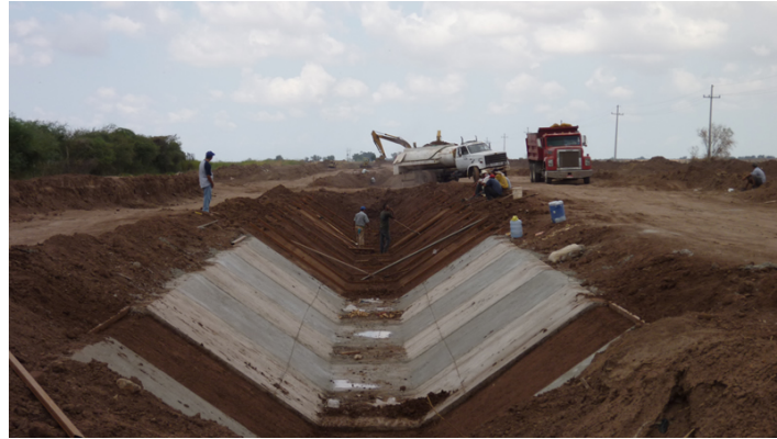
Figura 13: Construcción de un canal para riego
