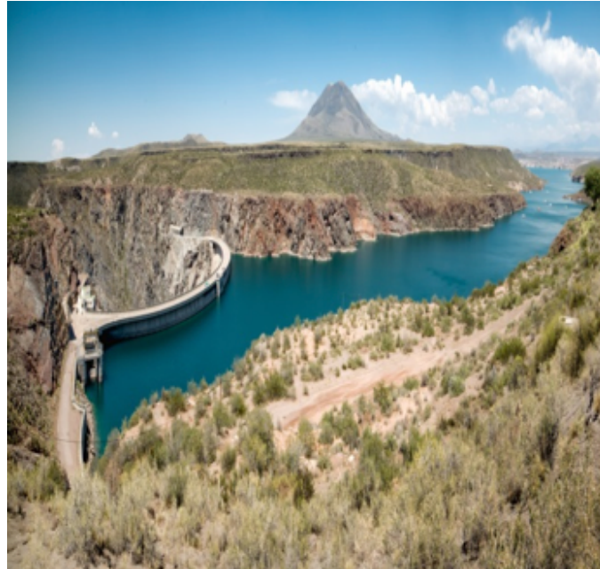
FIGURA 34. Presa de Agua del Toro.
