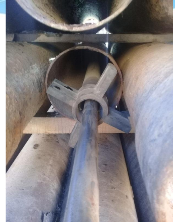
Cañería de impulsión caño camisa / eje estrella de goma
