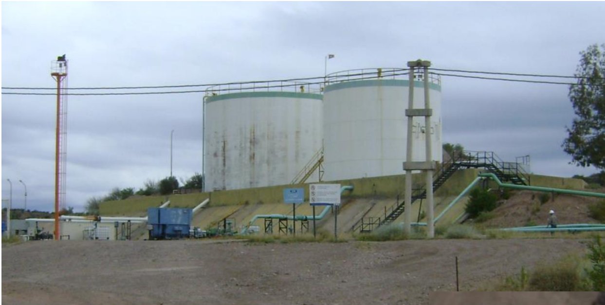
PLANTA DE INYECCION DE AGUA SALADA
