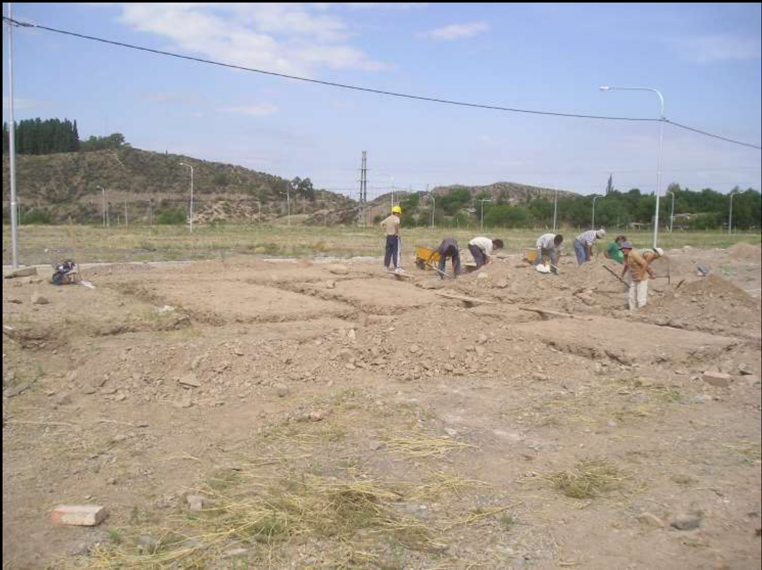
Excavación manual de bases y cimientos.
