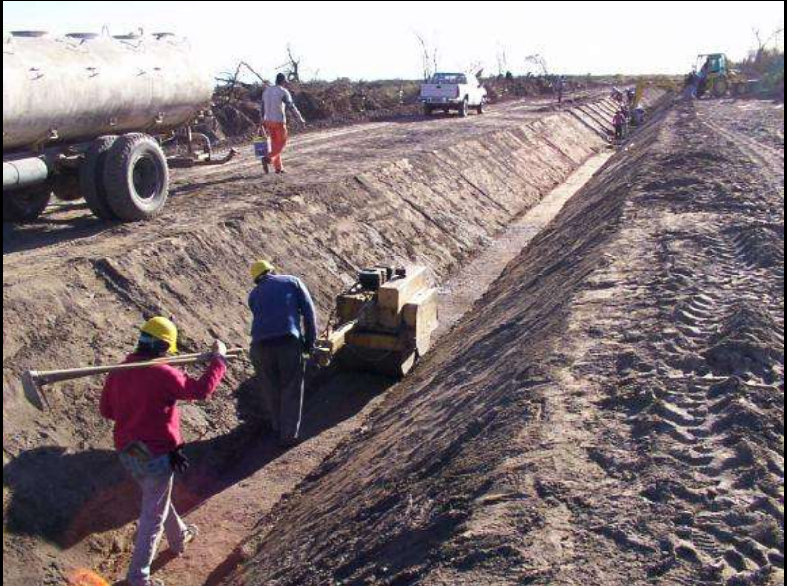
Rodillo vibratorio, autopropulsado con motor a explosión
