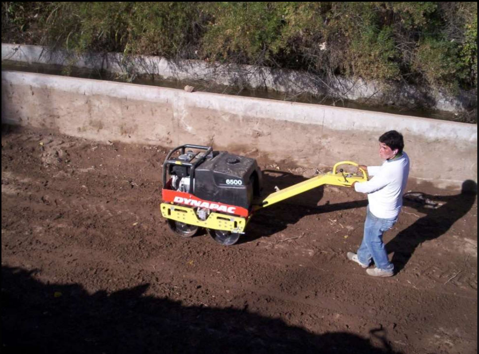
Rodillo vibratorio, autopropulsado con motor a explosión
