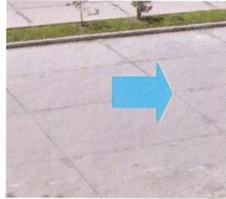
Pisos de hormigón
