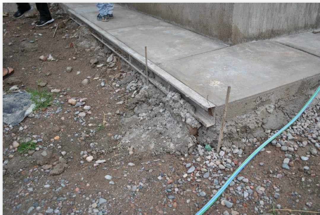
Piso y contrapiso exterior
