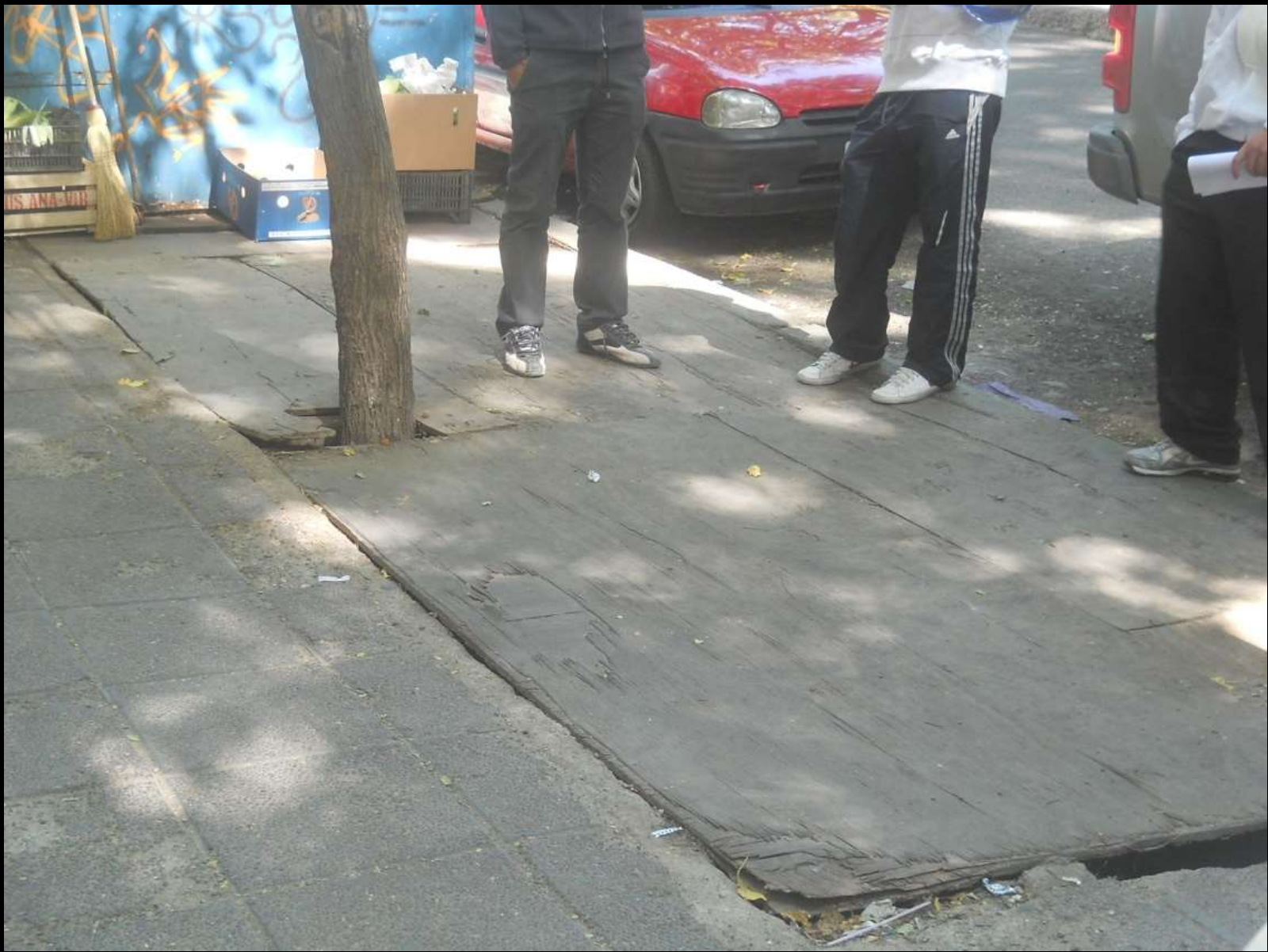
Ocupación parcial de veredas, tapado de acequia para tránsito peatonal
