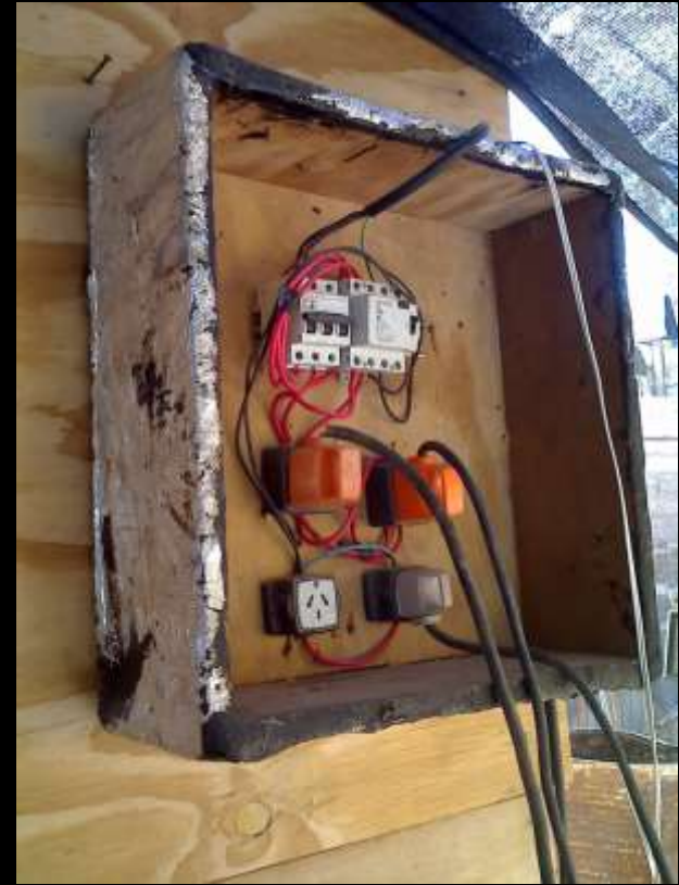
Caja de tablero interno de madera, llaves de corte, disyuntor y tomas
