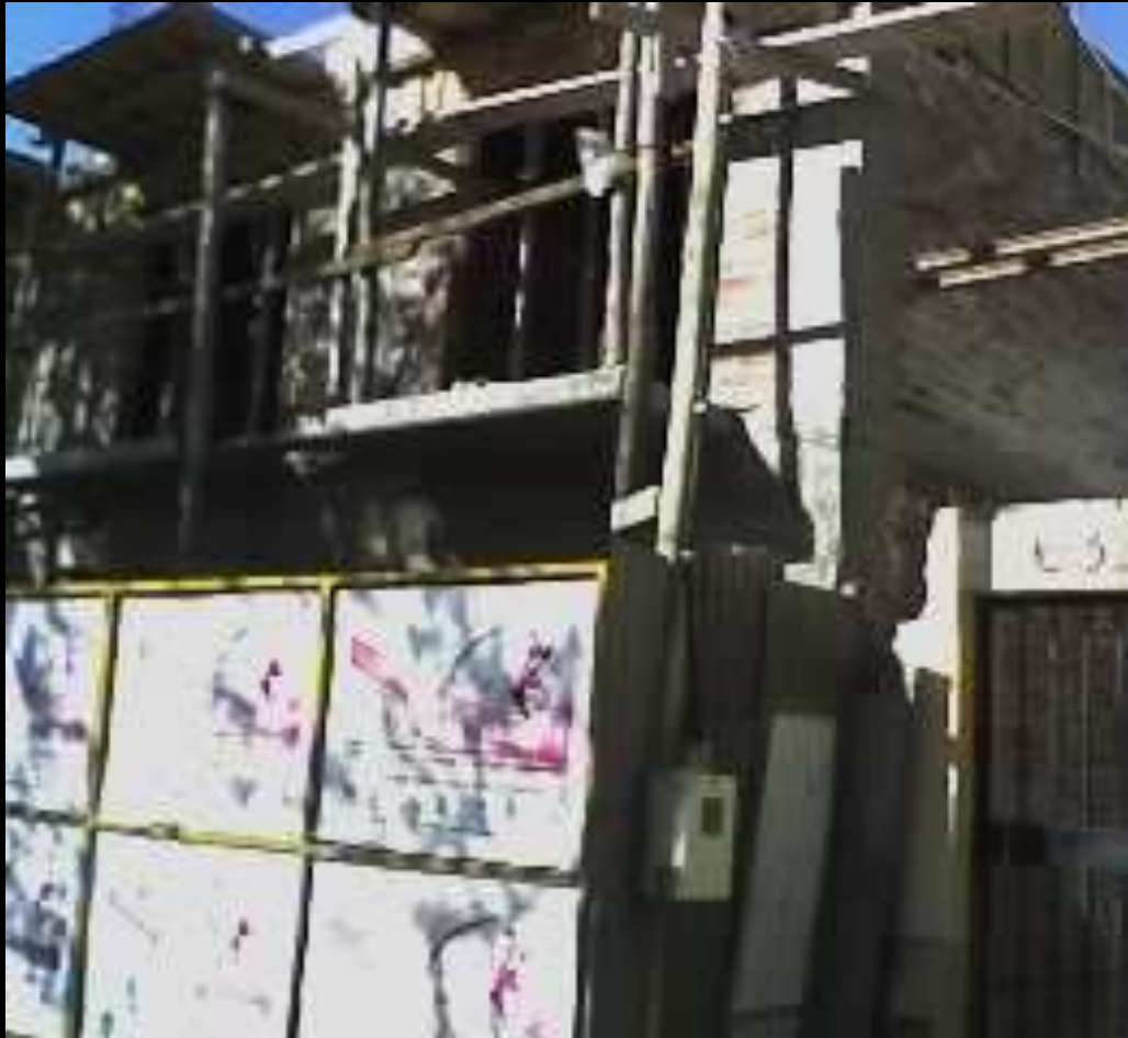
Poste de obra, ubicación en el frente de la obra
