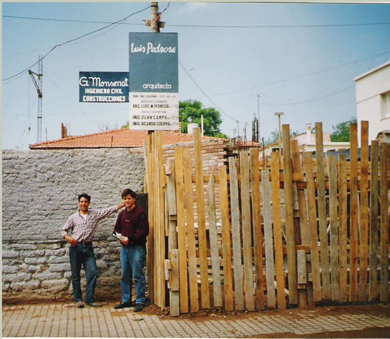
Cierre de obra tipo y cartel de obra
