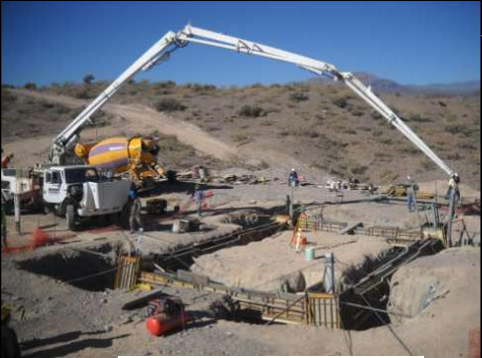
Colocación de hormigón mediante bomba móvil
