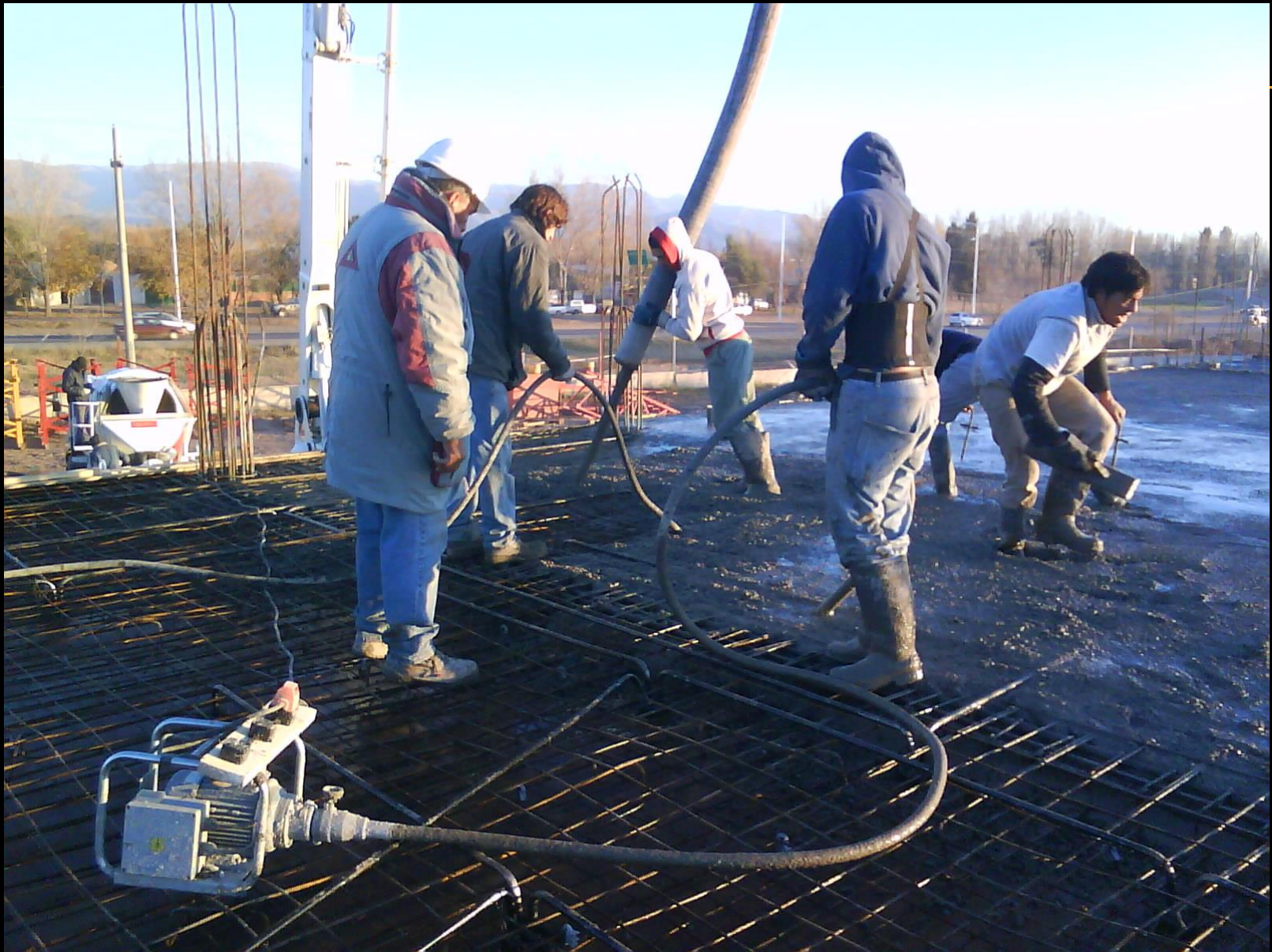
Colocación y vibrado de hormigón en losa
