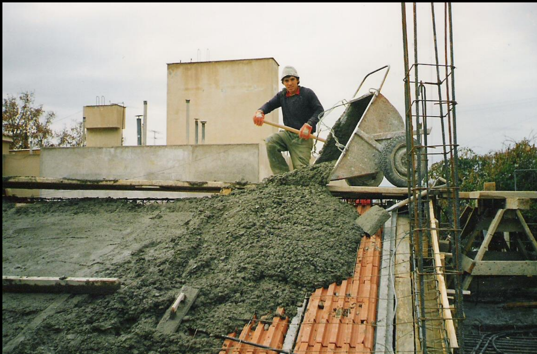
Colocación de hormigón mediante elevador y carretilla (balde)
