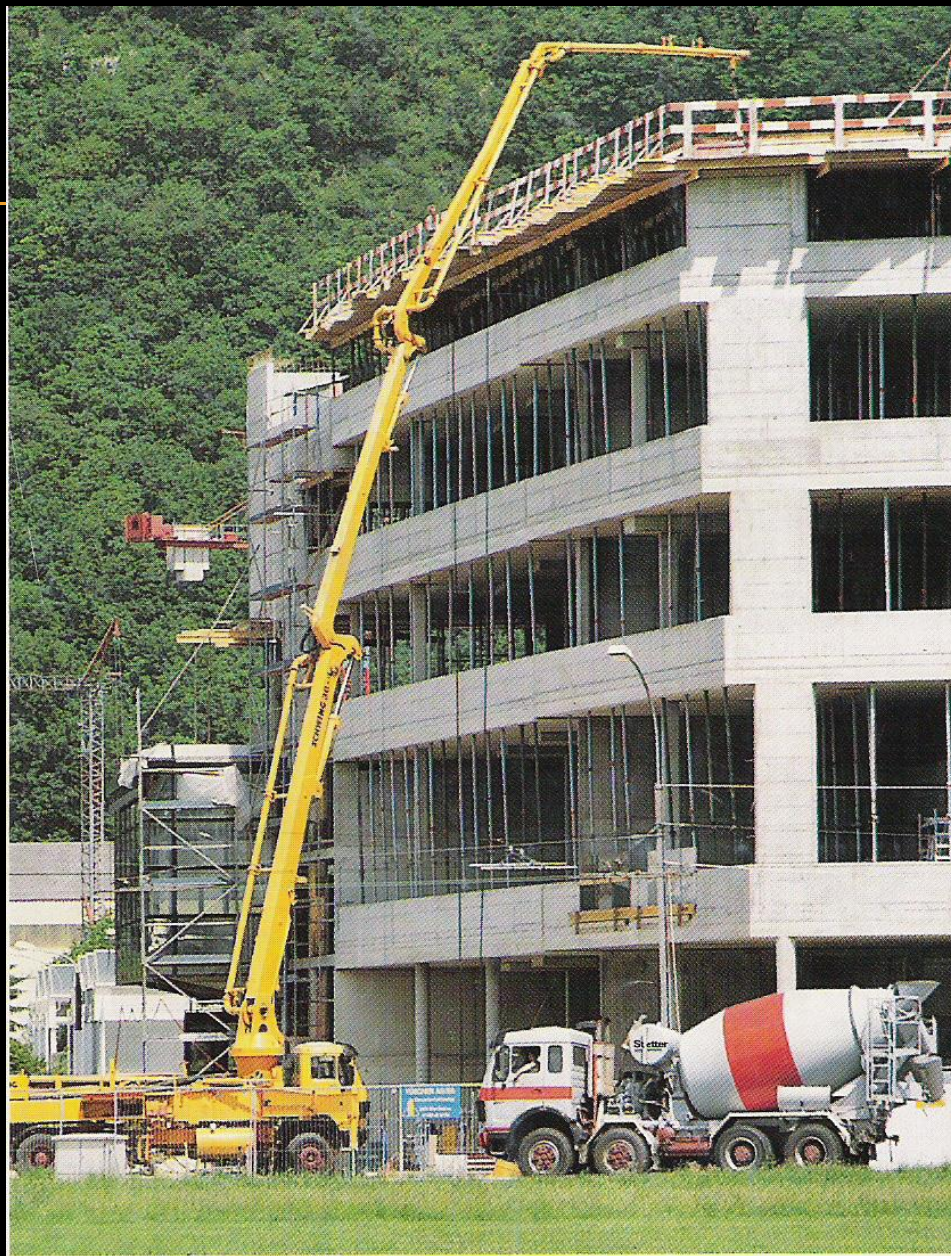
Colocación de hormigón mediante bomba móvil
