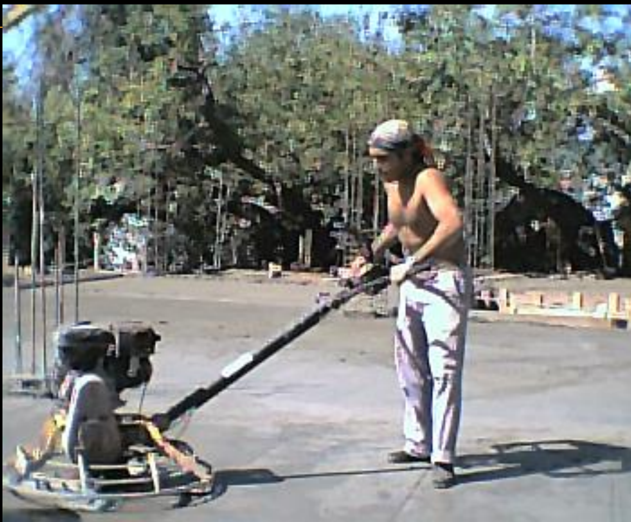
Alisado de hormigón mediante llana mecánica o alisadora
