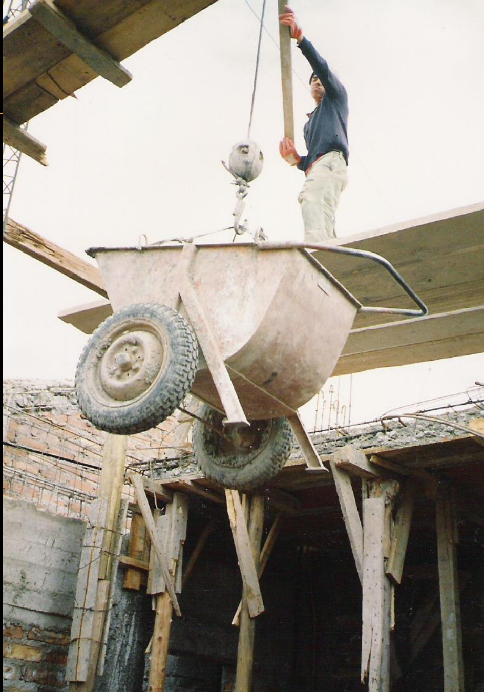
Elevación de hormigón mediante elevador y carretilla (balde)
