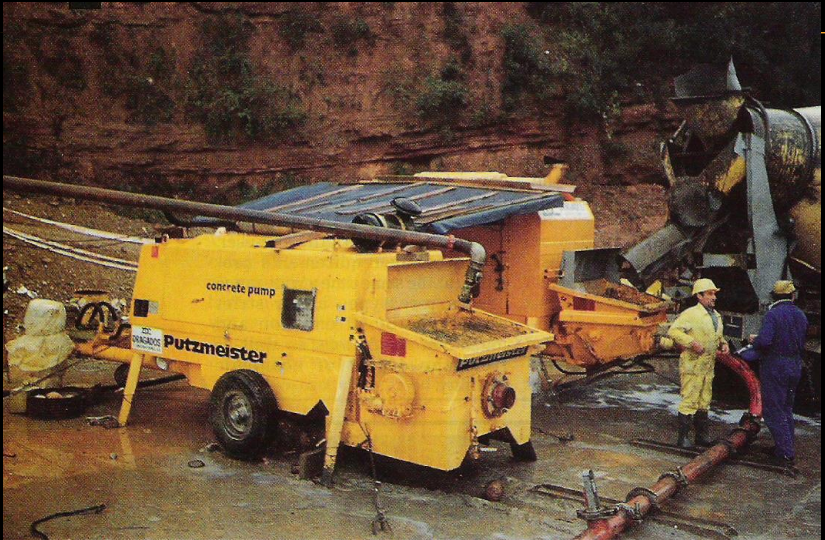
Colocación de hormigón mediante bomba fija
