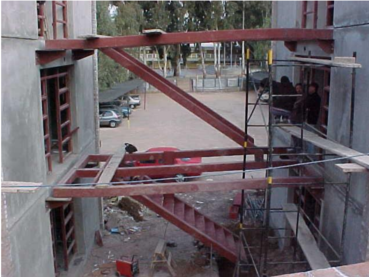
DETALLE ESTRUCTURA RESISTENTE DE LA ESCALERA
