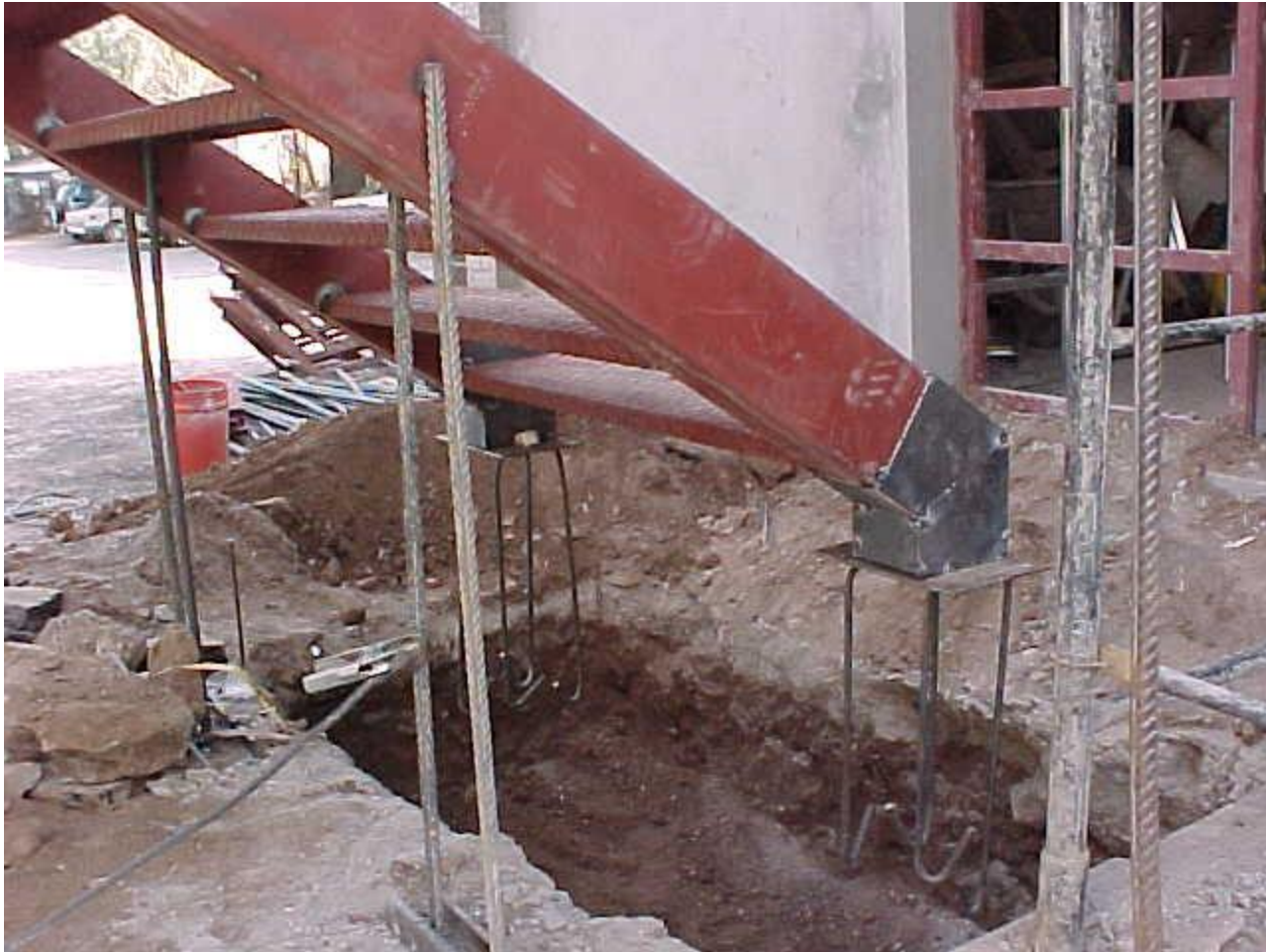
DETALLE ANCLAJE A BASES
