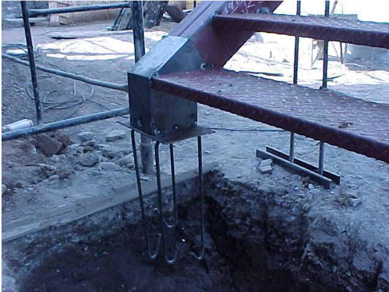
DETALLE ANCLAJE A BASES
