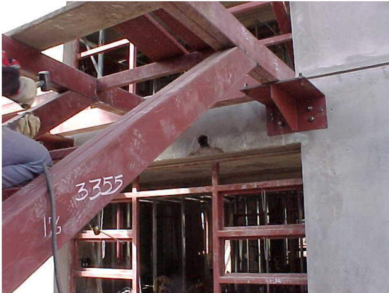
DETALLE CONSTRUCCION DE LA ESCALERA
