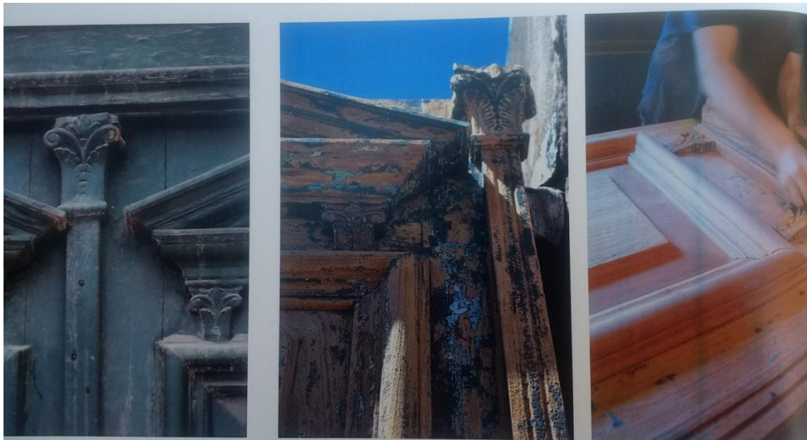
Proceso de restauración de carpinterías originales de fachada de cedro europeo.
