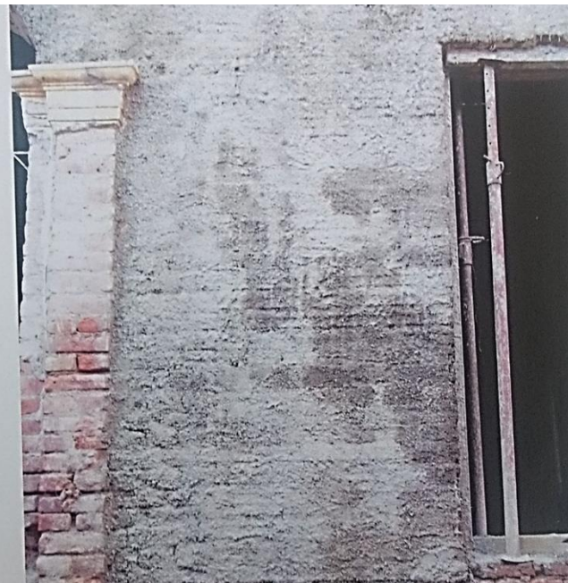
Proceso de consolidación del muro este del patio 2. Limpieza, cosido, armado de revoque de la grieta existente.
