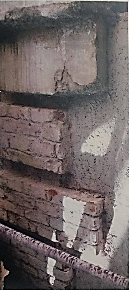
Proceso de restauración del almohadillado sur de fachada.
