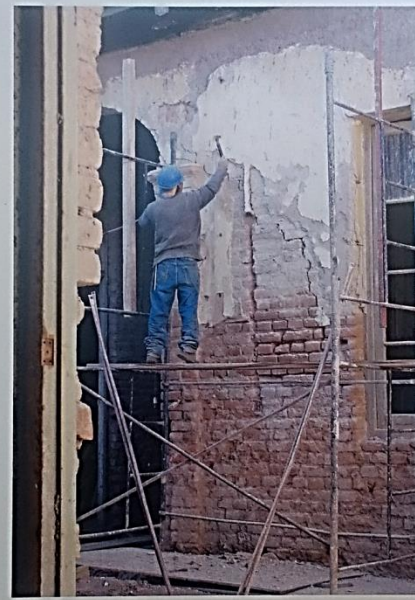
Proceso de consolidación del muro este del patio 2. Limpieza, cosido, armado de revoque de la grieta existente.
