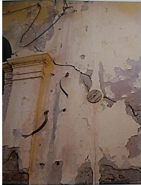
Proceso de consolidación del muro este del patio 2. Limpieza, cosido, armado de revoque de la grieta existente.
