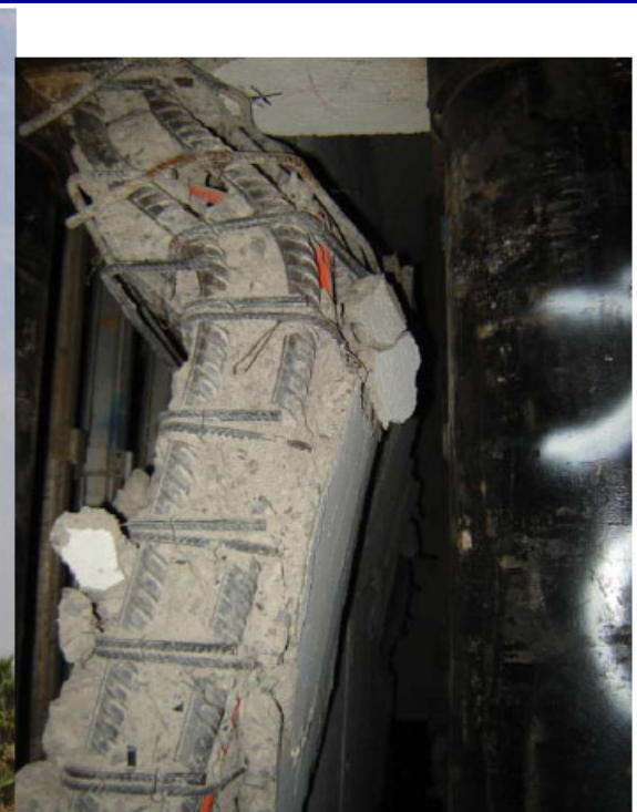
Fig. 16. Falla por pandeo de un tabique en planta baja en Hotel durante el terremoto de Christchurch en Febrero del 2011. El edificio sufrió grandes daños y debió ser demolido.
