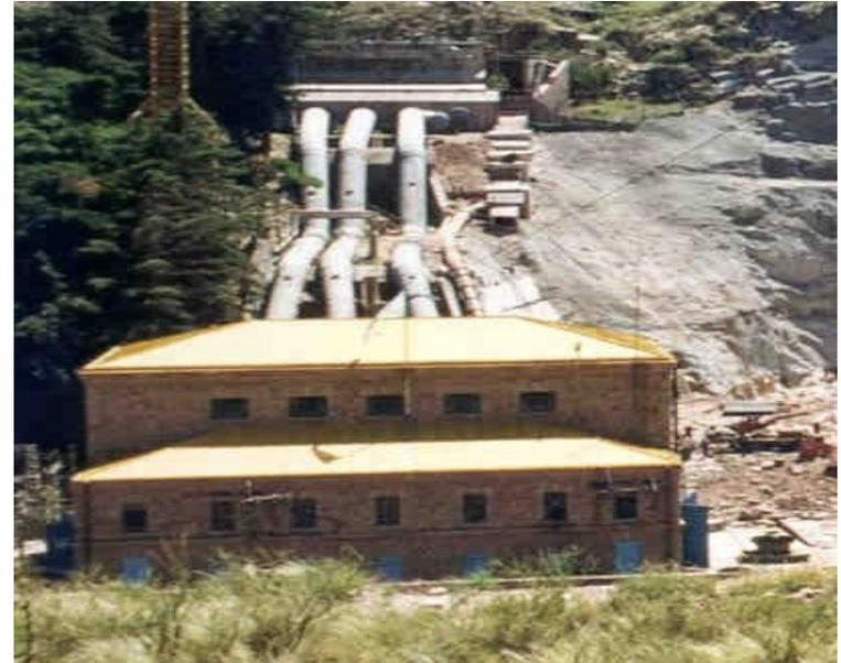
En general en un aprovechamiento hidroeléctrico las perturbaciones originadas en un transitorio hidráulico se manifiestan por un cambio de presión originadas por propagación de ondas de presión a través del sistema hidráulico.
